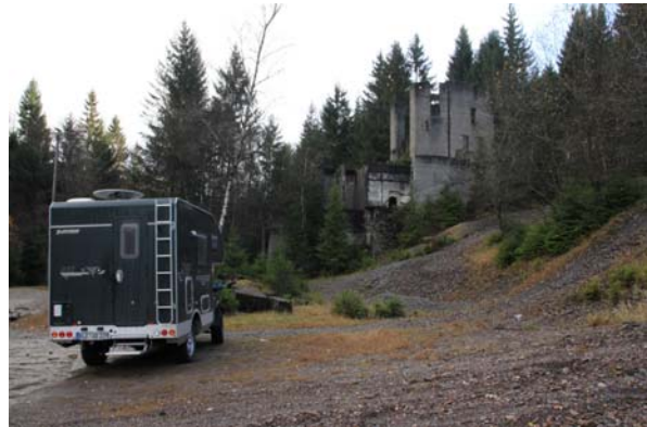
Abb. 4: Bergbauegebäude am Oberlauf des Geländes.
