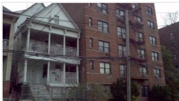
Oberirdische Stromkabel zur Versorgung von Privathaushalten in den Bronx. Foto des Autors.
