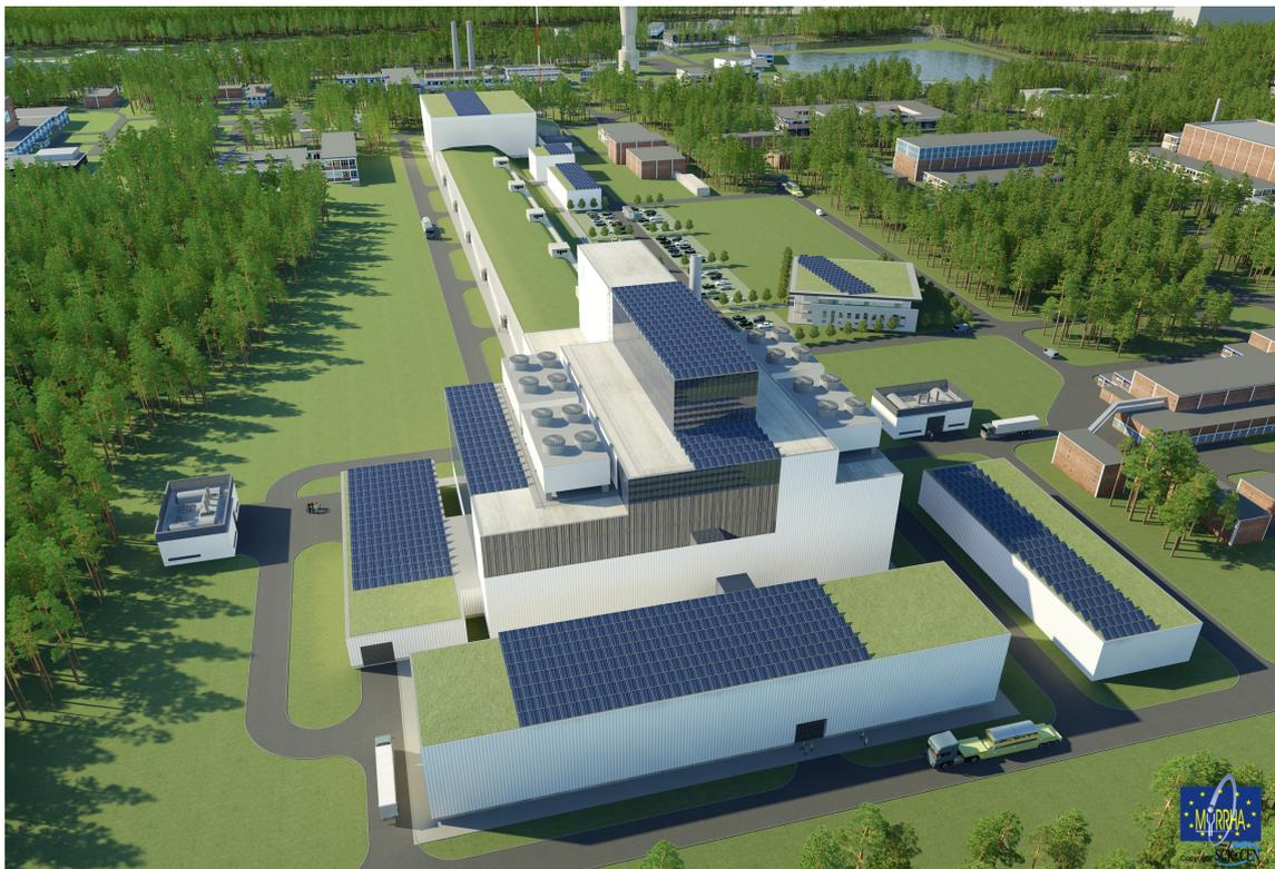
**Abbildung 5.1.:** Skizze von der geplanten MYRRHA-Anlage. Das Gebäude im hinteren Bereich beherbergt die Injektoren. Über den knapp 250 m langen Haupt-Linac gelangen die Protonen innerhalb des vorderen Gebäudes zum Reaktor. (Bildquelle: SCK • CEN, <http://myrrha.sckcen.be/>)
