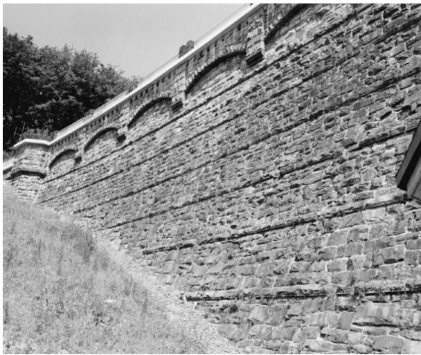
*Die Lingese-Talsperre, nach dem Entwurf von Prof. Intze in den Jahren 1897-1899 erbaut, im überarbeiteten Zustand 1999. Für Talsperrenbauer steht heute fest, daß die Erkenntnisse von Intze und Schmidt natürlich überbietbar waren. Auch die schwerste Talsperrenmauer unterliegt dem archimedischen Prinzip, d.b. der Auftrieb ist auch bei der solidesten Statik keine zu vernachlässigende Größe. Foto 1999, im Privatbesitz.*
