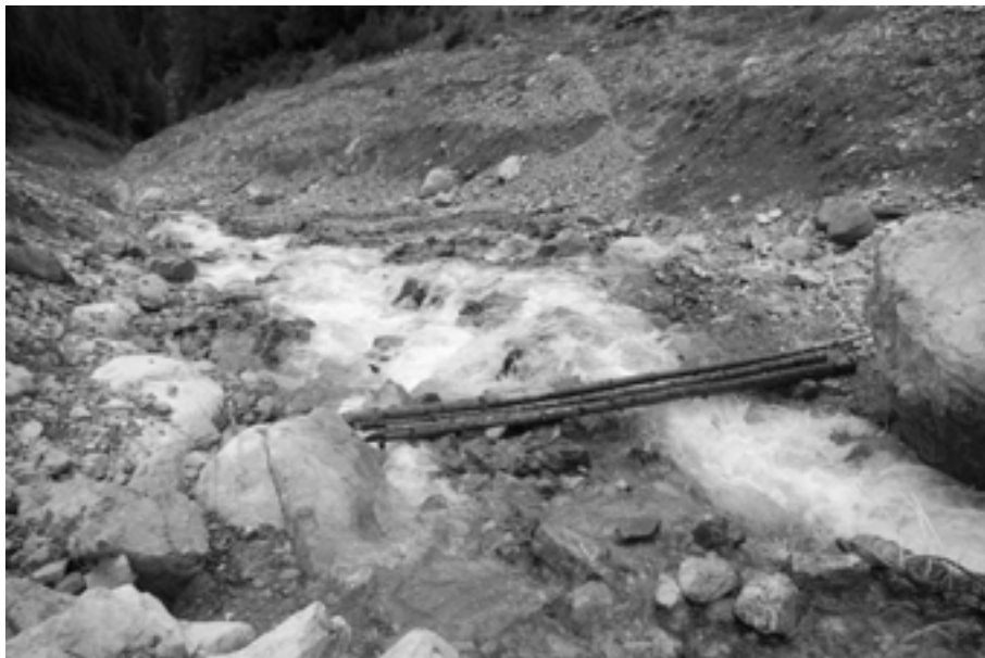
Abb. 27 Notbrücke - Ein Übergang nichts für schwache Nerven
