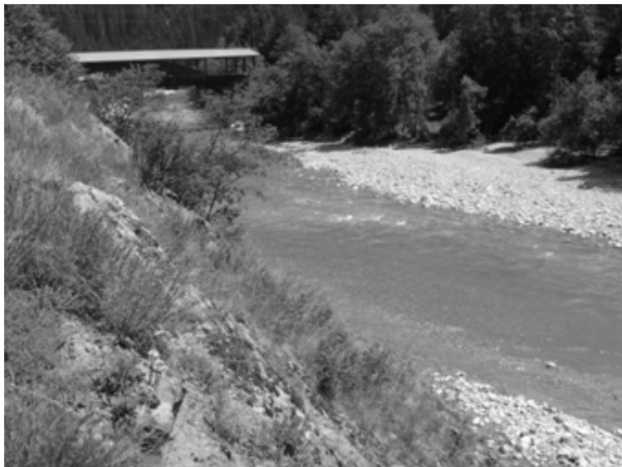
Abb. 1 Resgia - Holzbrücke, ab hier wurde Holz geflösst.
