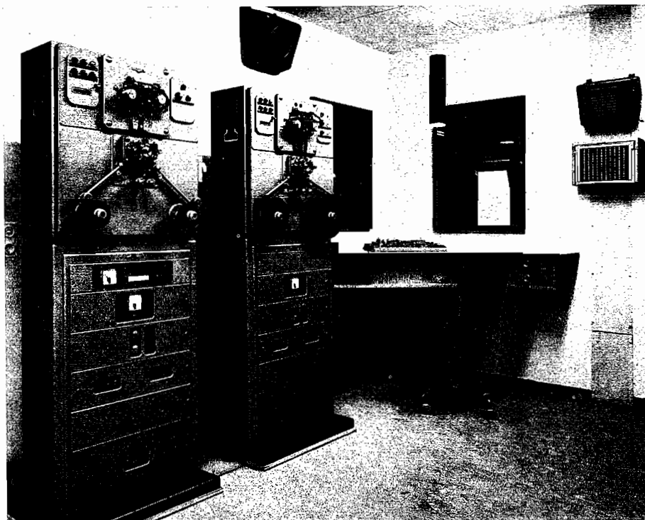
Abb. 4 Raum für Tonaufnahmegeräte
