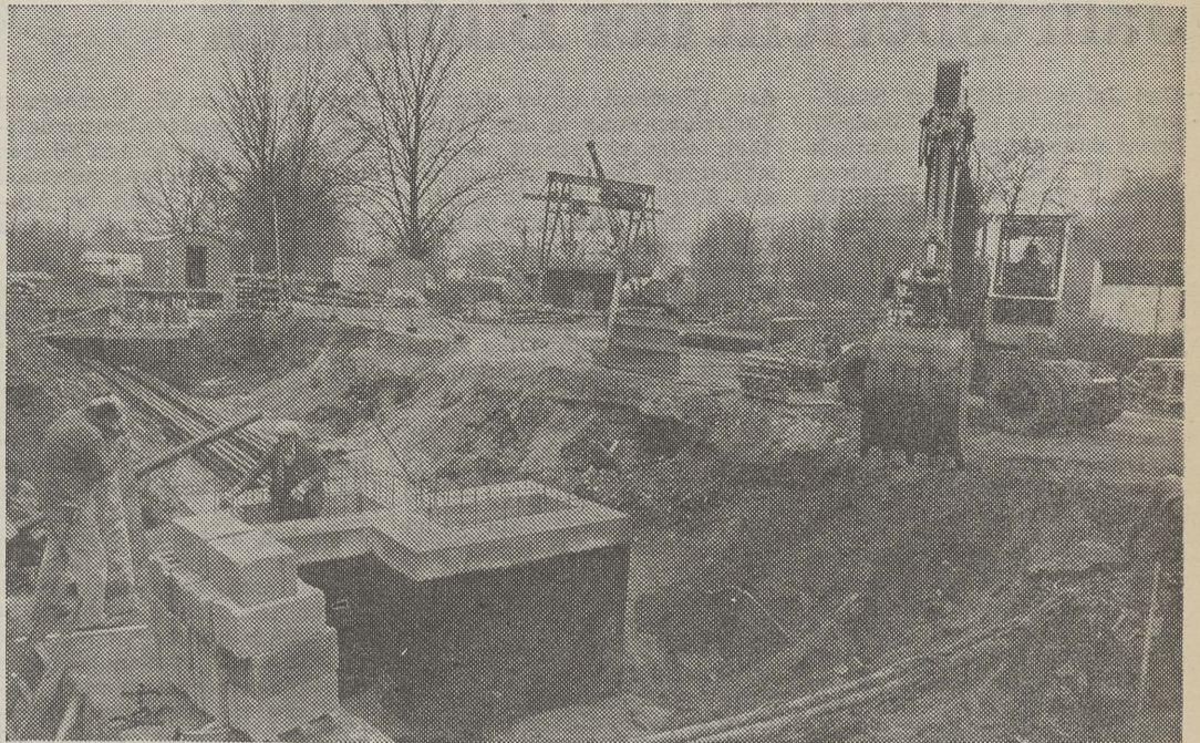
Umfangreiche Bauarbeiten sind notwendig, um das Zentrum der Psychiatrie und das Zentrum der Neurologie und Neurochirurgie an die Energiezentrale des Klinikums anzuschließen.
