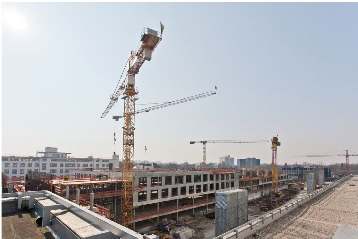
Die Baustelle der Erweiterung des Zentralgebäudes 23D bis F aus der Perspektive des Bettenhochhauses
