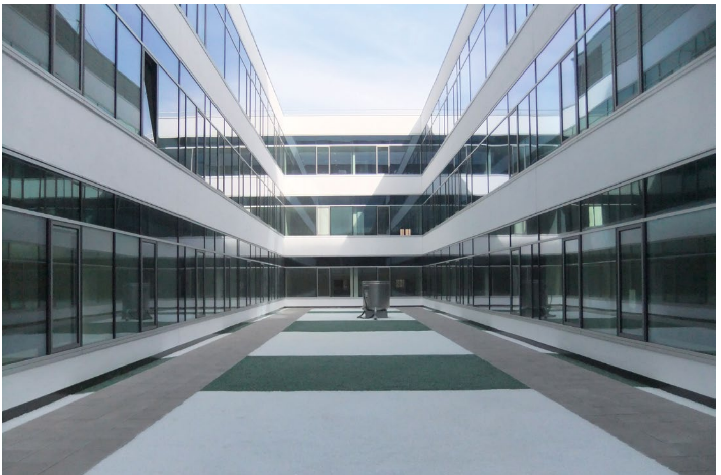
Die Lichthöfe erhellen die sanierten Sockelgeschosse im Haus 23A und B mit natürlichem Tageslicht.
