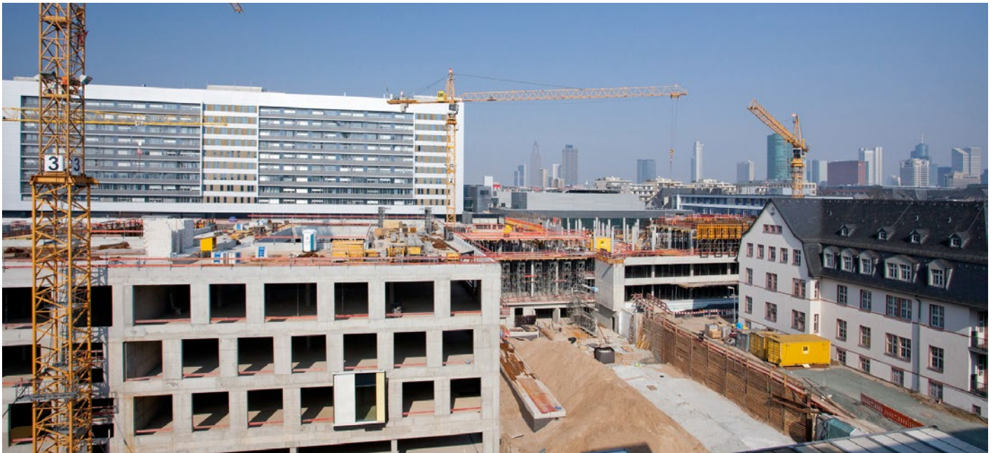
Die Baustelle des zweiten Bauabschnitts mit Blick auf die Rückseite des Bettenhochhauses
