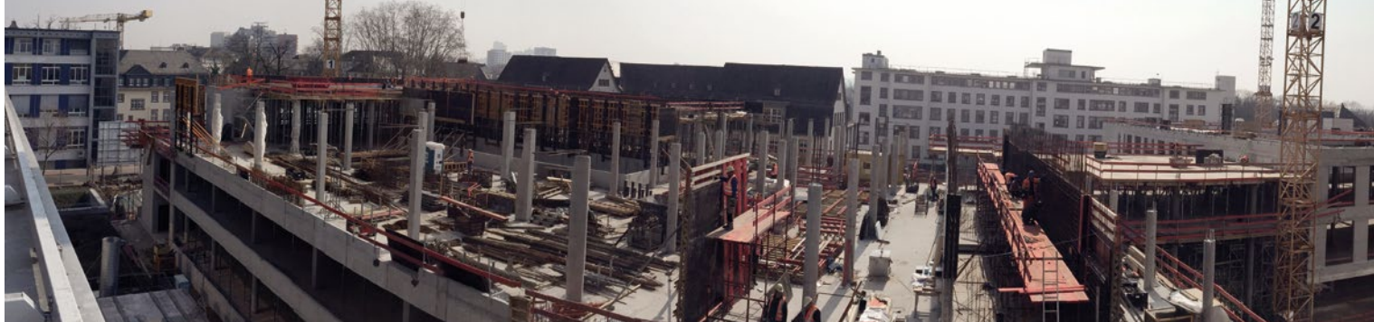
Die zentrale Baustelle des zweiten Bauabschnitts „Krankenversorgung“ in der Panoramaansicht
