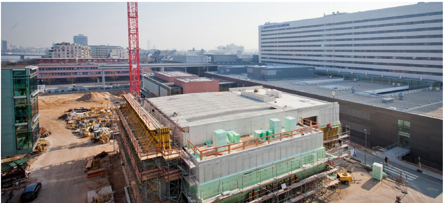
Die Baustelle des Hörsaalgebäudes „Audimax“ und rechts dahinter die fertiggestellten Sockelgeschosse 23A und B sowie das Bettenhochhaus des Zentralgebäudes
