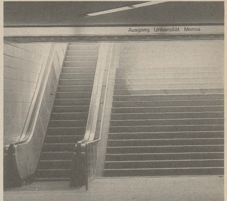
Behindertenfeindlich: Keine Aufzüge, nur Treppen in der U-Bahn-Station „Bockenheimer Warte“.
