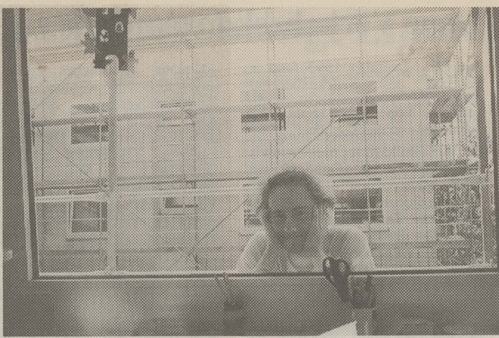
Die BewohnerInnen des Dessauer Hauses können den Umbau nicht mehr mit anhören. Doch die Baustelle schafft neue Perspektiven... (Foto: Sabine Gatz)
