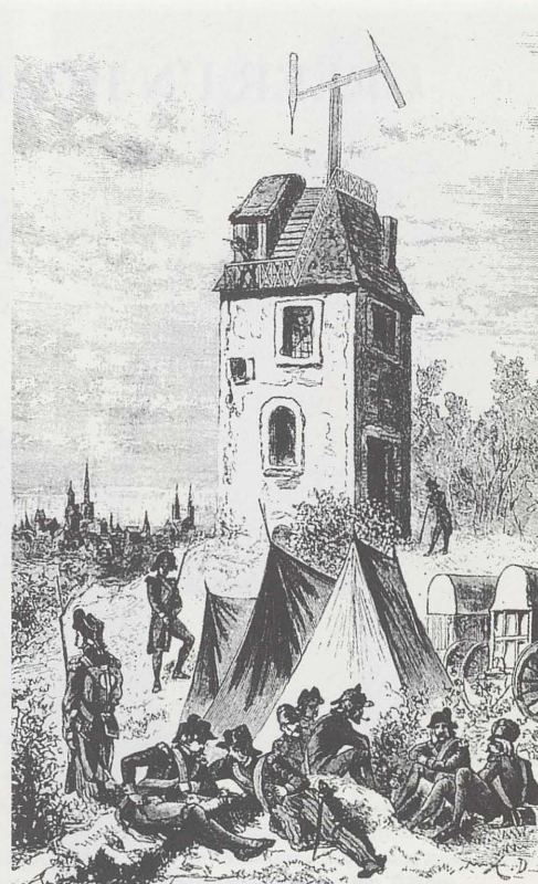
Der „Telegraph“, Erfindung des Bürgers Claude Chappe. Die beweglichen Zeiger ermöglichten ein System von insgesamt 196 verschiedenen optischen Zeichen, mit denen das Alphabet, aber auch ganze Wörter und Sätze kodiert werden konnten. [Aus: 4].
