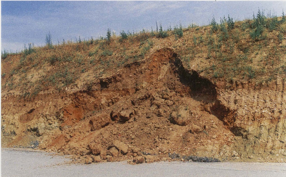
Abb. 11: Ausfließender Mergel über einer Mergelaufpressung (westlich der Straßenbrücke Weilbach/Bad Weilbach). Von solchen Verfließungen ist auch der aufgeschüttete Wall betroffen (bewachsener Teil), an anderen Stellen sogar großenteils zerstört.
