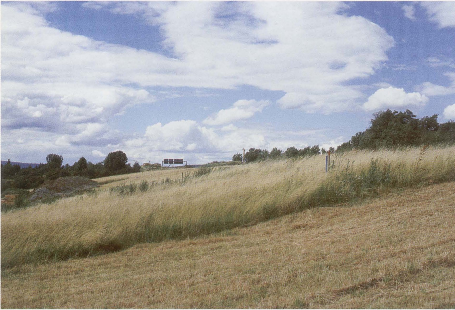
Abb. 6: Rutschungshang über dem Tunnelportal am Wiesbadener Autobahn-Kreuz (Wandersmann Süd): Die Grenze des gemähten Grünlandes spiegelt sehr gut die welligen Hangkonturen wider, die durch Rutschungen im Untergrund und Verfließungen von Mergel an der Oberfläche hervorgerufen werden.
