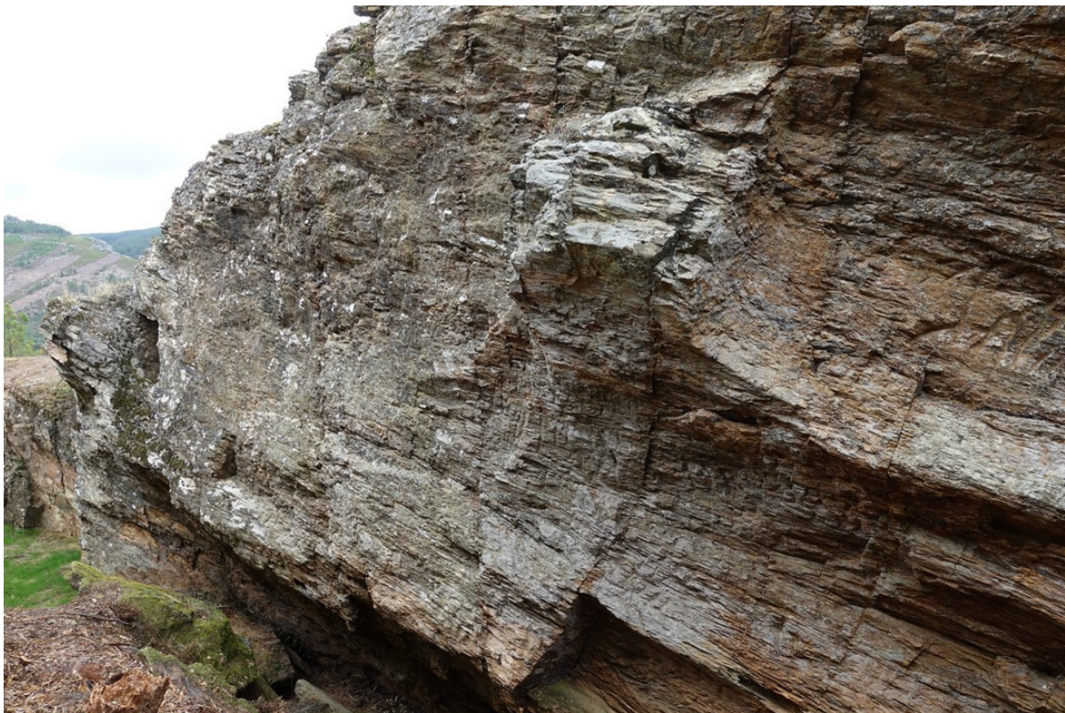
Abb. 6. Bearbeitungsspuren in der nordöstlichen Böschung. Gut erkennbar ist die Begrenzung der Arbeitsspuren nach oben, wo das Hangende eingebrochen ist. In der Mitte des Bildes befindet sich ein abgebrochener Rest, möglicherweise eines Sicherheitsbogens. Links im Bild ist der Durchbruch des Prospektionssschachts (E in Abb. 8) durch die Böschung erkennbar (s. Abb. 9). Foto R. Wahl-Clerici.
