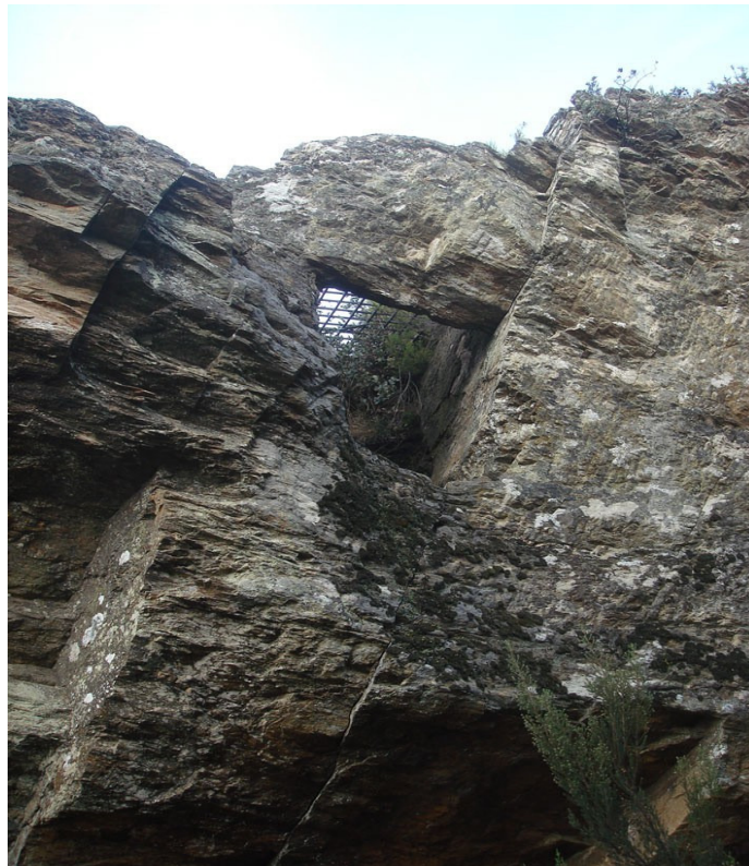
Abb. 10. Durch den Abbau wurde der Prospektionsschacht E durchbrochen. Foto R. Wahl-Clerici.
