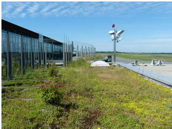
Abb. 8: Dortmund Airport, Dachgarten auf der Besucherterrasse hinter einer Sicherheitsglaswand (10.06.2017, W. HESSEL).
