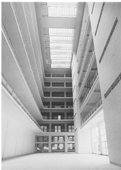
Abb. 16: Die kleine Halle nach der Rekonstruktion ca. 1997
