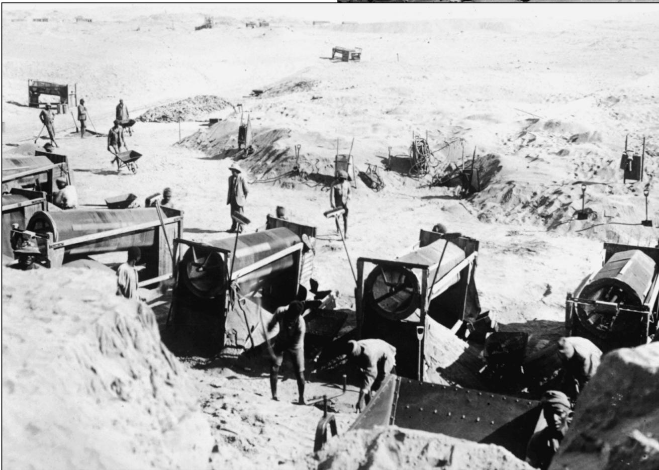
Maschinelle Bearbeitung des diamantenthaltigen Wüstensandes
