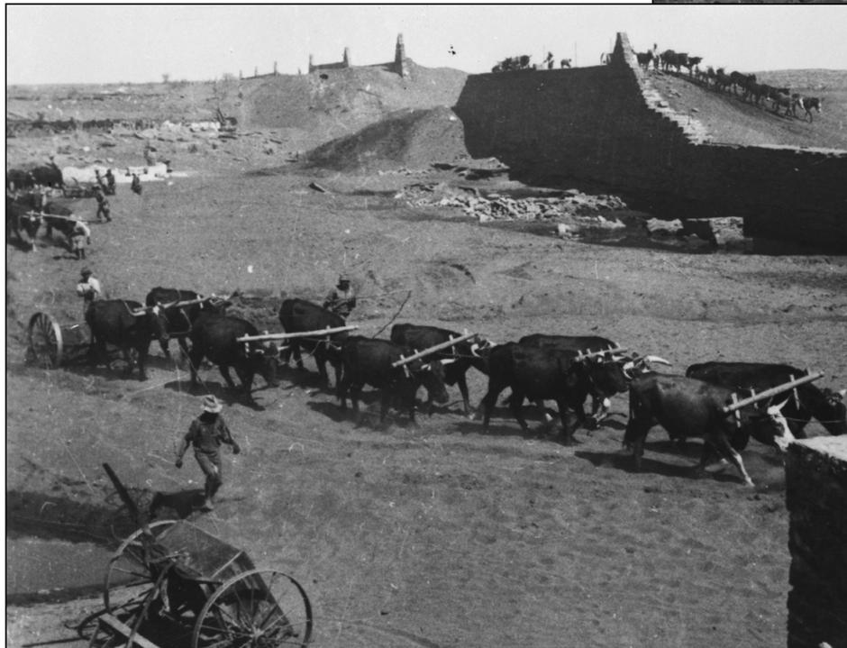
Erneuerung des Staudammes in den dreißiger Jahren: Die Kernmauer wird neu eingeschüttet. Im Vordergrund das Staubecken und Ochsen-
