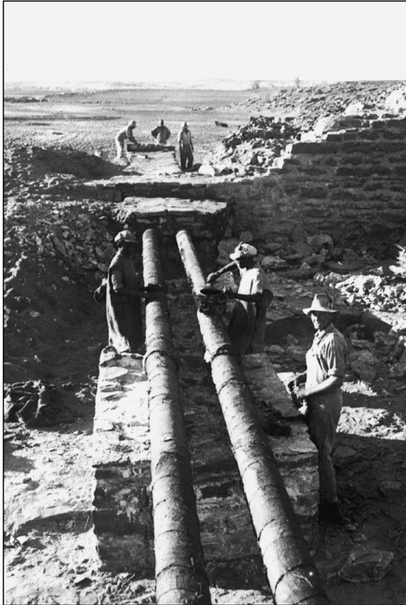
Einteerer der Entnahmerohre vor dem Einmauern und Einschütten (1935)
