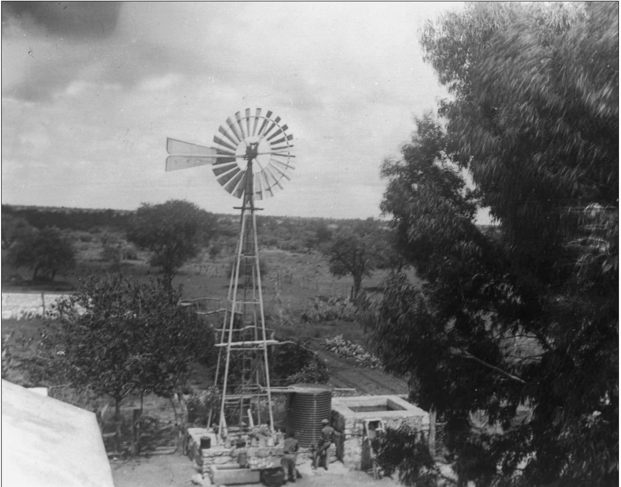
Windmotor, der das Grundwasser hoch pumpt, daneben das Wasserbecken
