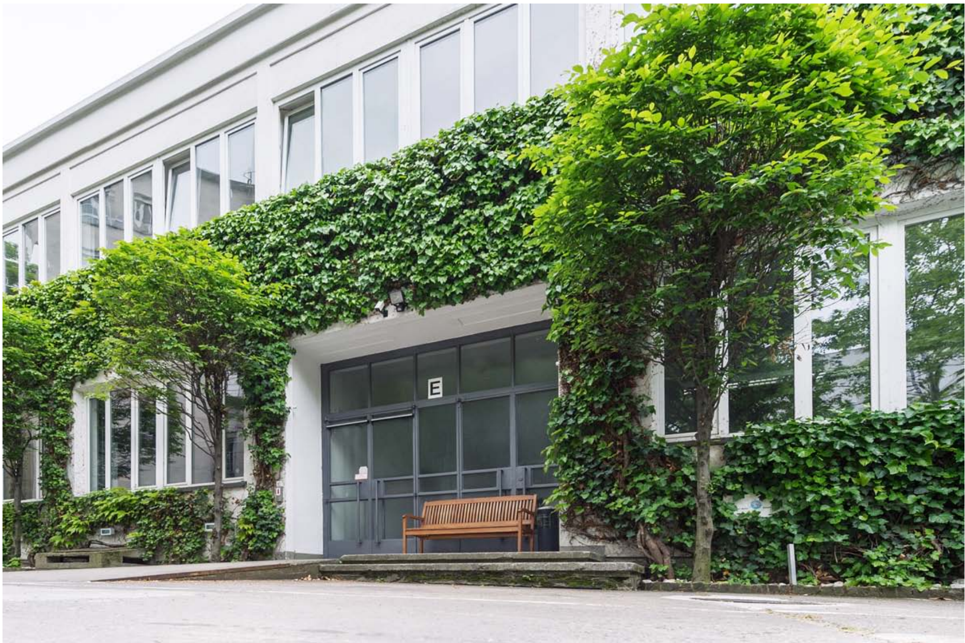
Außenansicht und Eingangsbereich des ISOE (Foto: Jürgen Mai)
