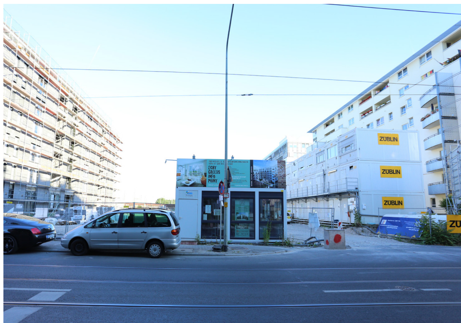
Abb. 9 Adlerquartiere Louis am Park und Harry's Lofts, Kleyerstraße, Aug. 2014 (Foto: David Schommer)
