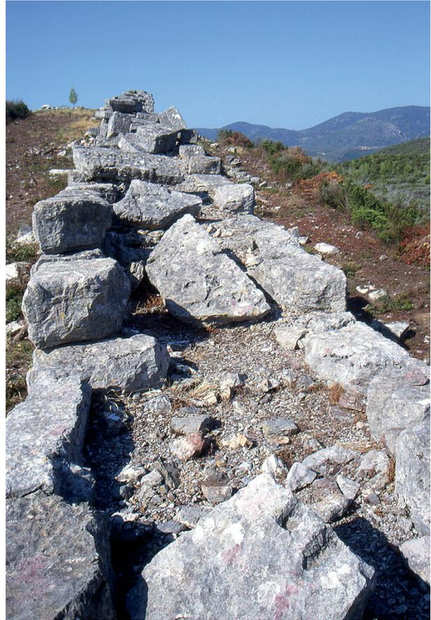
Abb. 5 Kurtine südwestlich von Turm T 6 mit zwei Mauerschalen und in die Füllung ragenden Bindern (Foto S. Müth)
