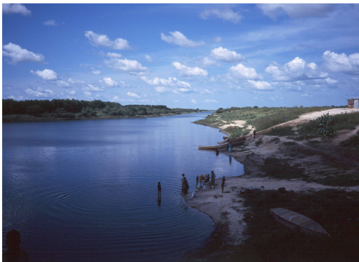
Abb: 18: Blick von der Pumpstation Kirenowa nach Norden entlang des Hauptzufuhrkanals vom Tschadsee (September 1995)
