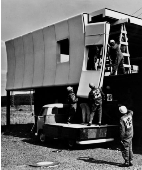
Aufbau des Prototypen im Mai 1968 zwischen 7 und 17 Uhr aus 13 Dach- und 26 Wandelementen aus GFK; Bild: Wolfgang Feierbach.
