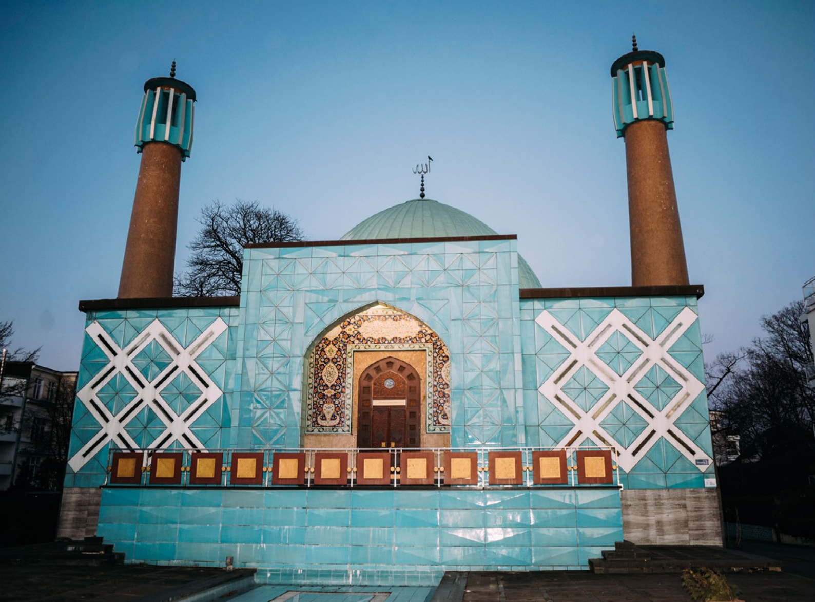
Außenansicht der in den 1960er-Jahren erbauten Imam-Ali Moschee.
