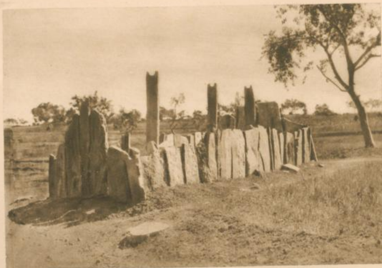
Gerüst eines Hauses aus gespaltenen Granitsteinplatten zwischen Mysore und Kikeri.
