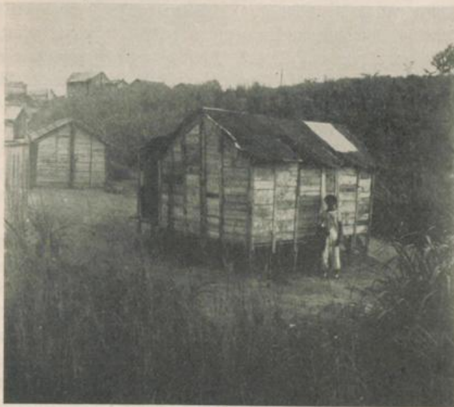
Siedlungen auf dem Plateau von Matadi: Ein moderner Pfahlbau aus Bierkistenbrettern.
