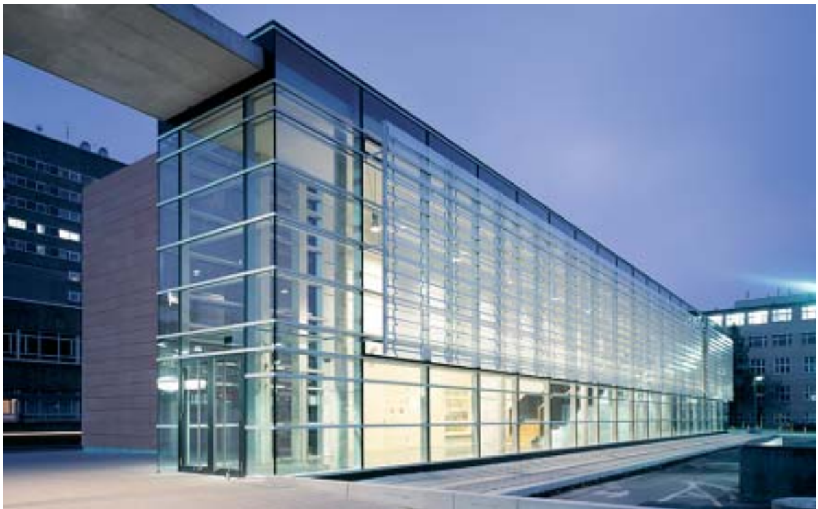
Nach knapp zweijähriger Bauzeit wurde das neue Hörsaal-Zentrum im Februar eingeweiht
