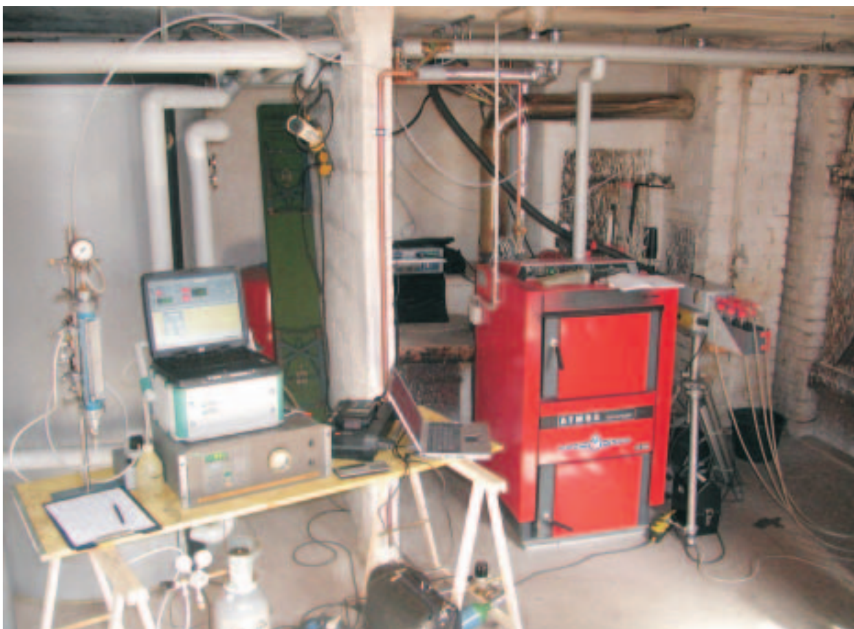
Abbildung 4.3-1 Messaufbau an einer Holzfeuerungsanlage
