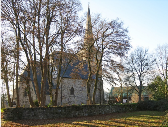
Abb. 1: Bruchsteinmauer zwischen Stiepeler Dorfkirche mit Kirchhof und sich nördl. anschließender Freifläche (Stiepel, Bochum/NRW, 19.12.2020, M. Lubienski).
