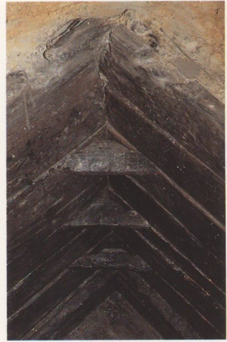
Abb. 9 Detail aus Abb. 8 mit den Trittstufen in den Ecken.
