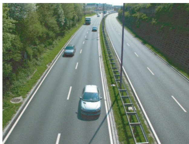
Abb. 1: Beidseitig ausgeführte, doppellagige, offenporige Asphaltfahrbahndeckschicht (Augsburg, Innenstadt, Tempobeschränkung 70 km/h) als Lärminderungsmaßnahme. Die Reduktion gegenüber dem vorherigen Belag beträgt etwa 7 dB(A).
