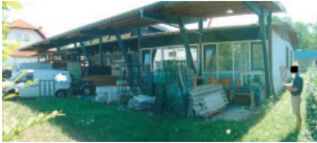
Gelände eines Gewerbebetriebs nach Geschäftsaufgabe
