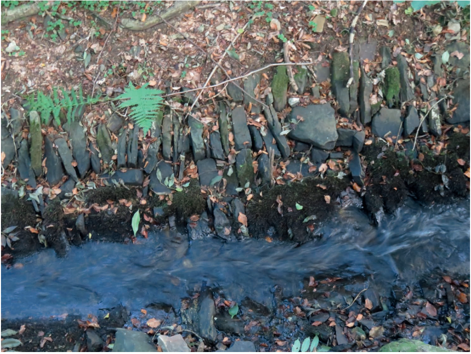
Abb. 1: Ufer- und Sohlenbefestigung „Nassauer Gestück“ am Silberbach nördlich Schloßborn; 29. 9. 2016, K. Willkomm. – The “Nassauer Gestück” bank and channel bed reinforcement at Silberbach, north of Schlossborn.
