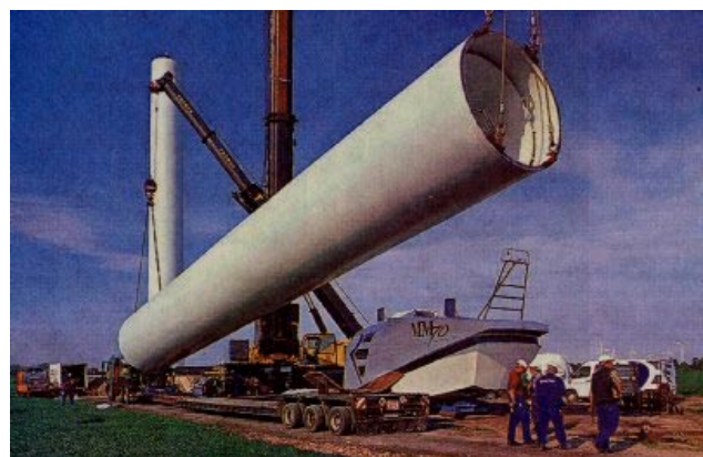
Aufstellen einer Windkraftanlage Foto: decker + wulf
