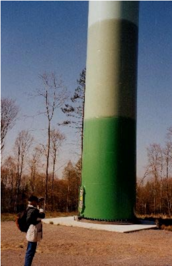
Dimensionen des Turmssockels; durch landschaftsbezogene Farbgebung soll die Anlage besser in die Umgebung eingebunden werden. Foto: M. Theis
