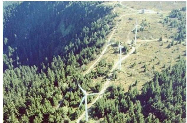
Erschließungswege zwischen Windkraftanlagen im Bereich der Hornisgrinde im Nordschwarzwald Foto: R. Steinmetz
