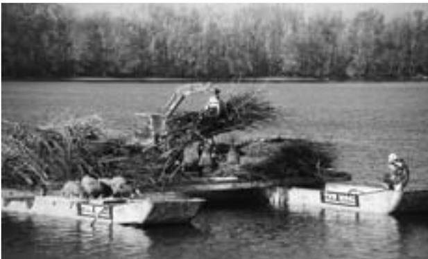
Mit schwerem Gerät werden Holzbündel in der ehemaligen Kiesgrube versenkt. Foto: R. Steinmetz
