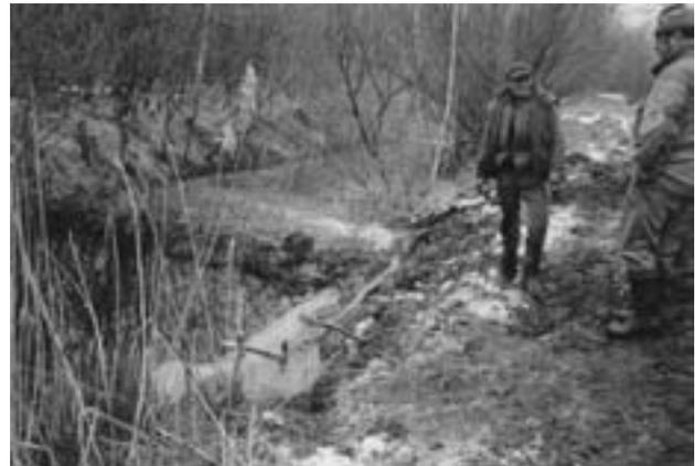
Einbau einer Drainage in einen Biberdamm zur Wasserstands-senkung. Überschwemmungen werden behoben und dem Biber bleibt eine ausreichende Wassertiefe.
