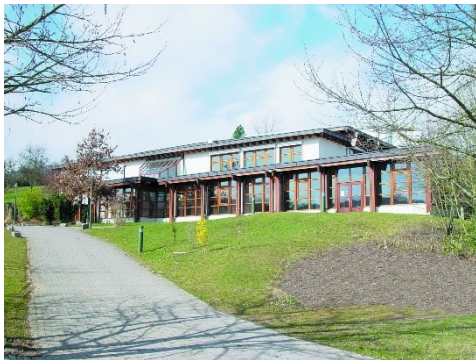
Im Jahr 1995 wurde das BBW-Gebäude rechts neben dem Haupteingang vergrößert, indem ein Konferenz- und Prüfungsraum angebaut wurde.
