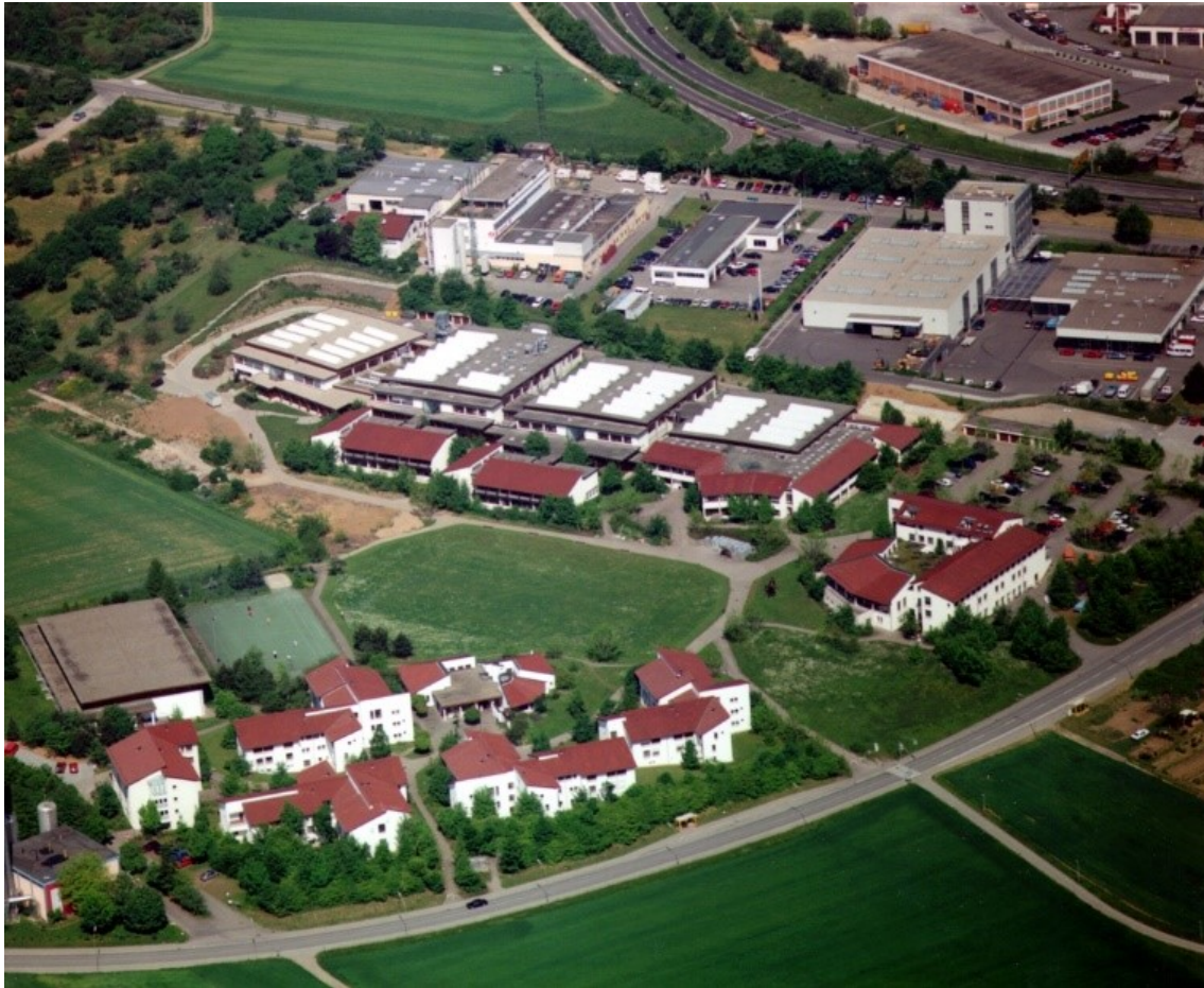
Das BBW mit der 1995 erbauten vierten Werkhalle, aber noch ohne die 2011 erfolgte Vergrößerung der Mensa. Rechts die Mensa und die Verwaltungsgebäude, in denen damals auch der Vorstand seinen Sitz hatte. Links die Internatshäuser.
