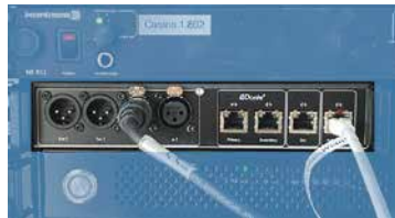
Einbau im Technik-Rack Casino 1.801.
