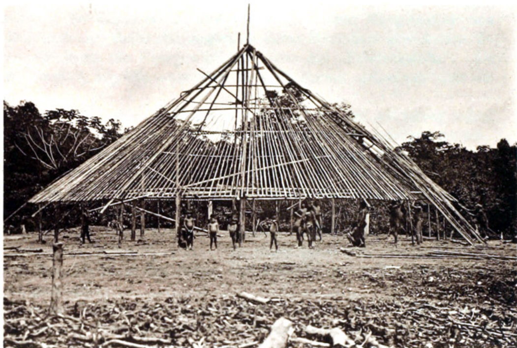
97. Neubaugerüst von Mauakunya.
