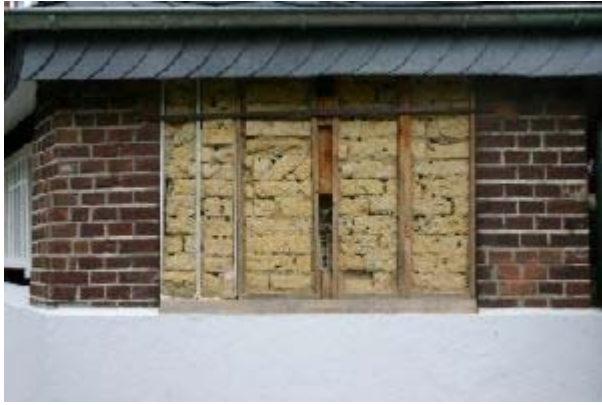
Abb. 2: Die Bretterrahmen mit passgenau gesägten Ziegelblöcken sind in einen Mauerdurchbruch des Gartenpavillons (am Naturschutzzentrum in Rees-Bienen) bündig eingefügt. (Foto: M. Brühne)
