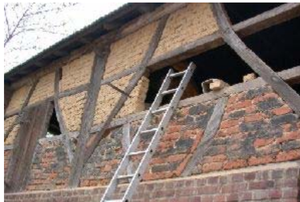
Abb. 1: Ausschneiden eines Ziegelblockes mit einem langen Sägeblatt (Foto: F.-J. Niehues)
