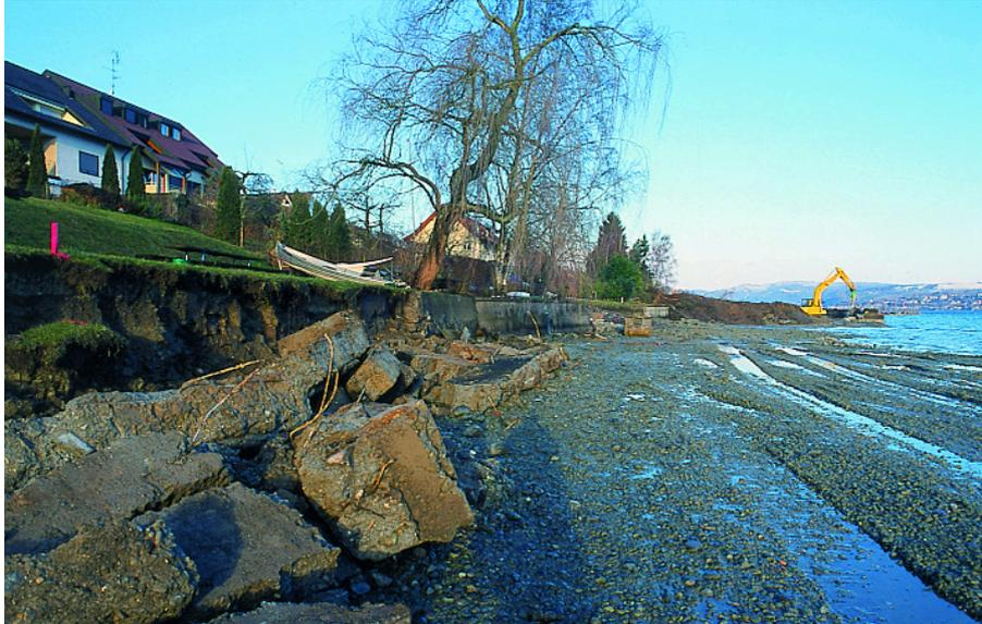
Wie die Verbauung selbst, ist auch die Renaturierung der Bodenseeufer mit beträchtlichem technischen Aufwand verbunden; hier wird eine Ufermauer abgebaut und das Gelände anschließend mit Kies der Böschung angeglichen.
