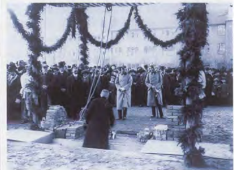
Grundsteinlegung für eines der ersten Universitätsinstitute – das Zoologische Institut – am 20. November 1913.
