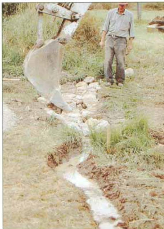
Abb. 168: Naturnahe Umgestaltung eines Fließgewässers: Intensive Bauleitung erforderlich - Wiesenbächle im Bauzustand (Aufn.: Aland 1991).
