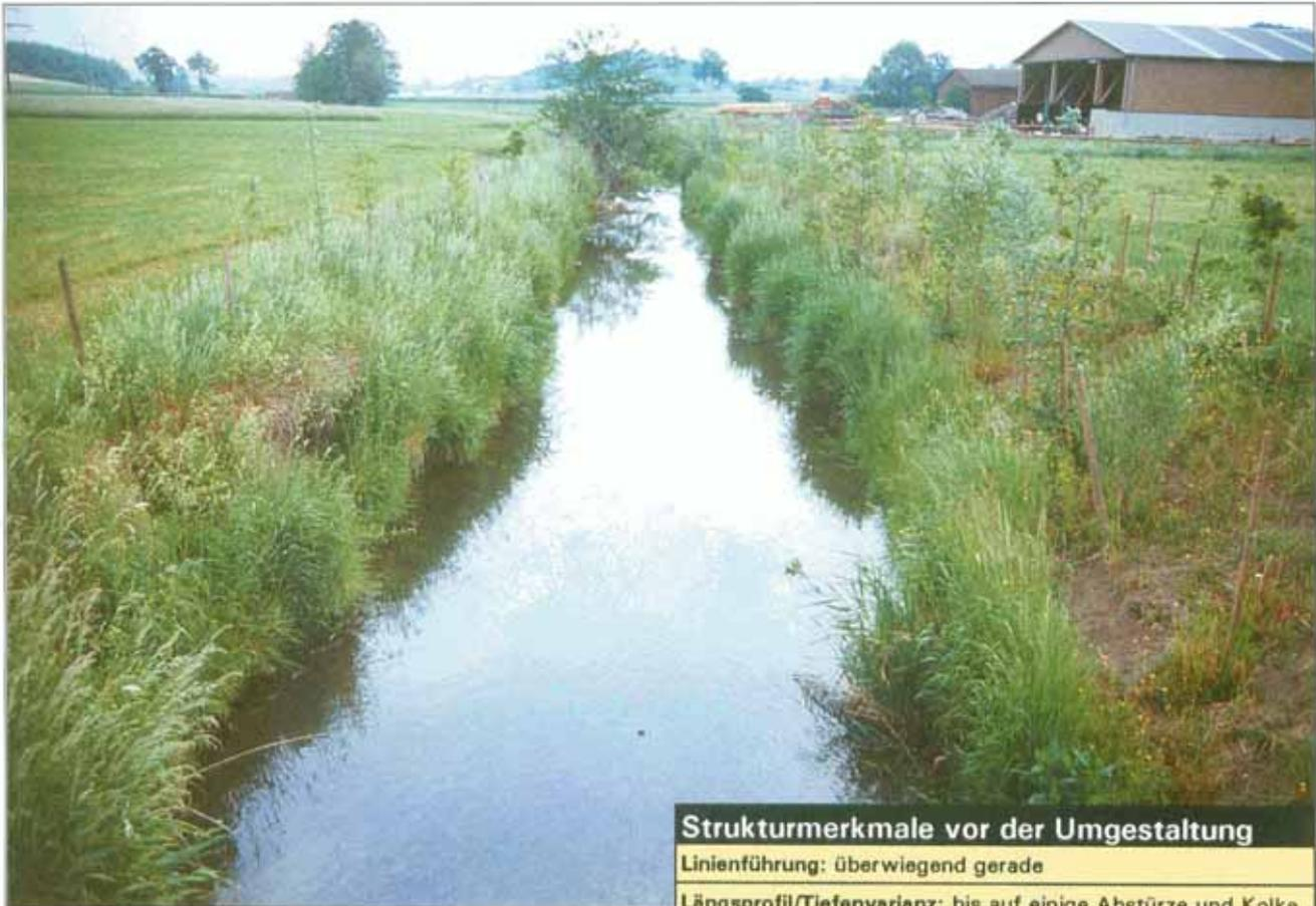
Abb. 23: Speltach, Altausbau: gerade Linienführung (Aufn.: LfU 1992).
