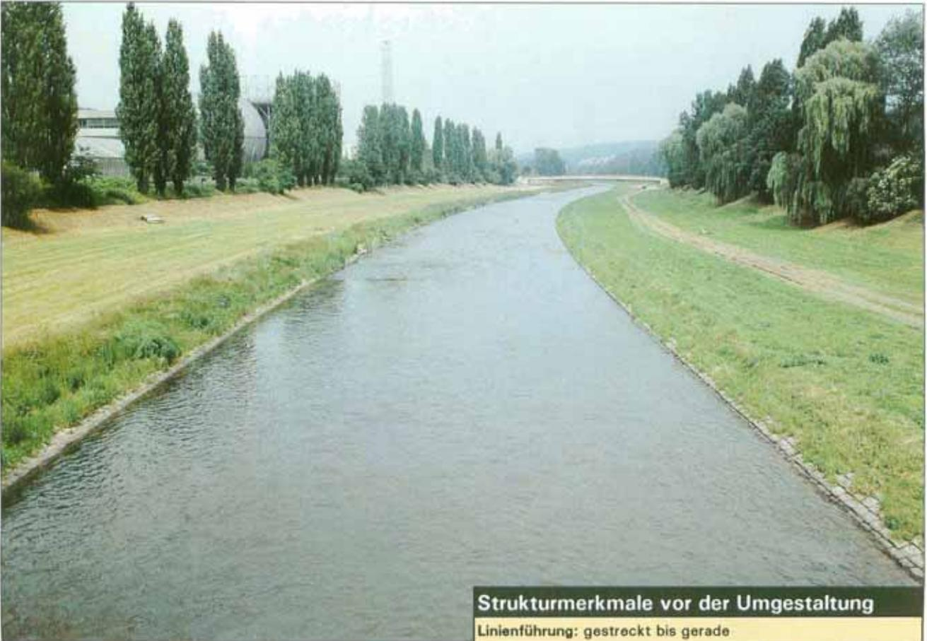
Abb. 136: Enz in Pforzheim vor naturnaher Umgestaltung: Begradigte Linienführung, einheitliches Doppeltrapezprofil (Auf.: LfU 1989).
