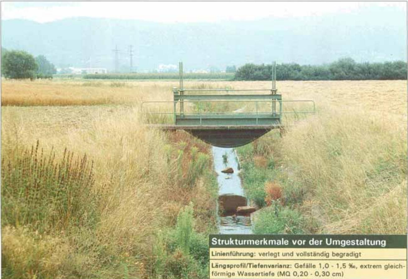
Abb. 74: Das Sulzbächle und seine Nebengewässer waren vorher extrem begradigt, das einheitliche Trapezprofil z.T. mit Sohlschalen ausgelegt (Aufn.: LfU 1991).
