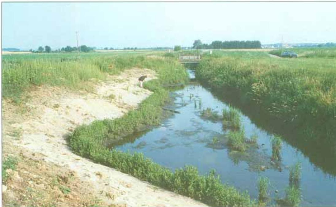
Abb. 44: Kehrgraben: Durch taschenförmige Aufweitungen und Abflachungen erhielt der Graben punktuell naturnahe Laufstrukturen (Aufn.: Aland 1992).
