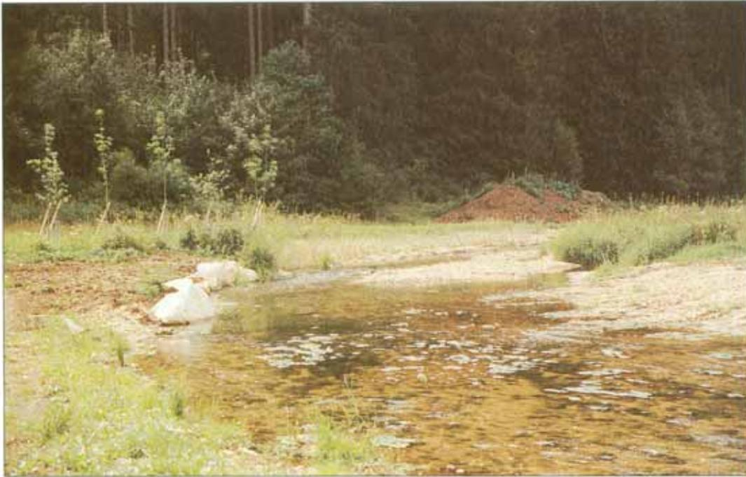
Abb. 133: Aus den gewonnenen Erfahrungen des 1. und 2. Bauabschnitts entwickeltes, neues Umgestaltungskonzept für Bauabschnitt 3 - Breiteres Profil, weniger Feinmodellierung, keine aufwendigen Sicherungsmaßnahmen (Aufn.: LfU 1995).
