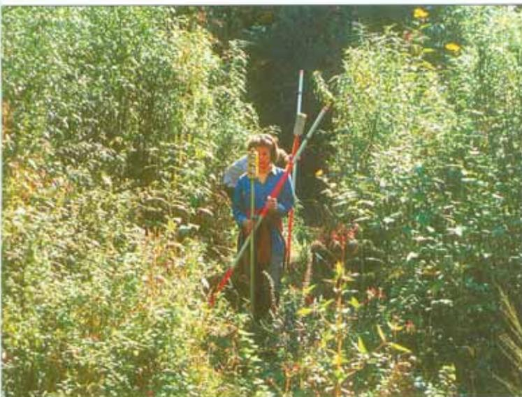
Abb. 8: Einmessung von Querprofilen an der Murr (Aufn.: LfU 1995).
