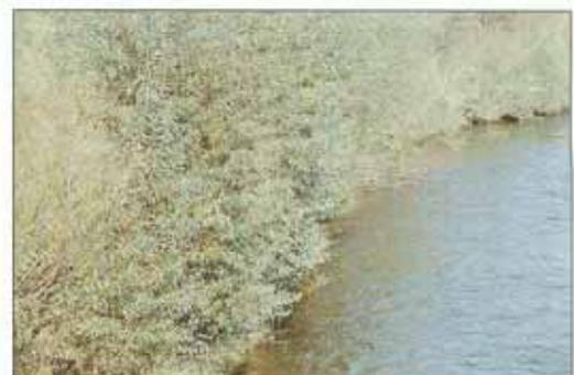
Abb. 140: Naturgemäße Bauweisen, Weidenfaschine am Mittelwasser (Aufn.: LfU 1995).
