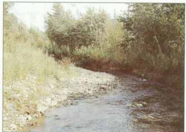
Abb. 109: Krähenbach, Bauabschnitt 1: Uferbank - ein naturnahes Strukturelement (Aufn.: LfU 1995).
