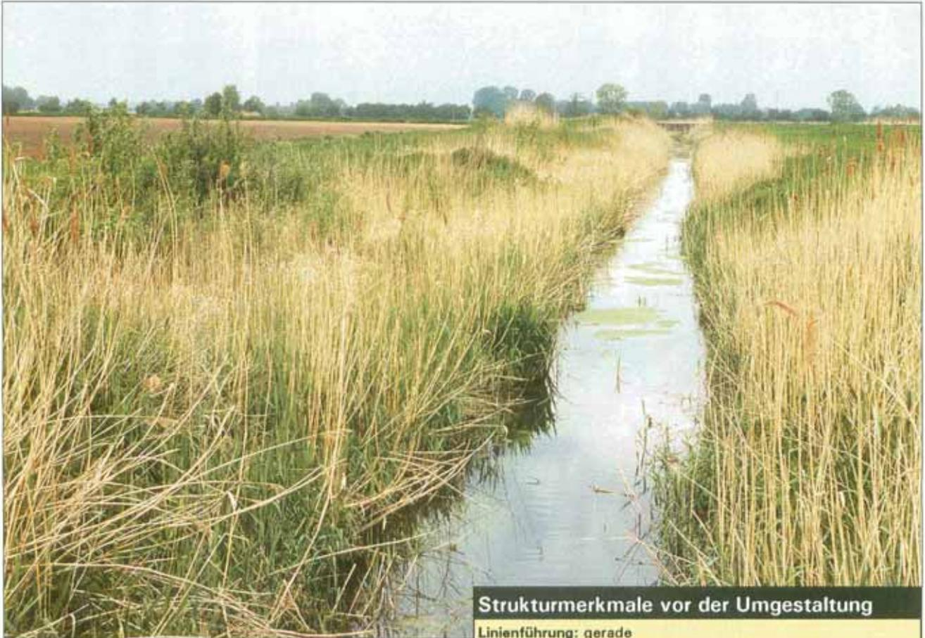
Abb. 39: Kehrgraben, Altausbau: gerade Linienführung, Trapezprofil (Aufn.: LfU 1995).
