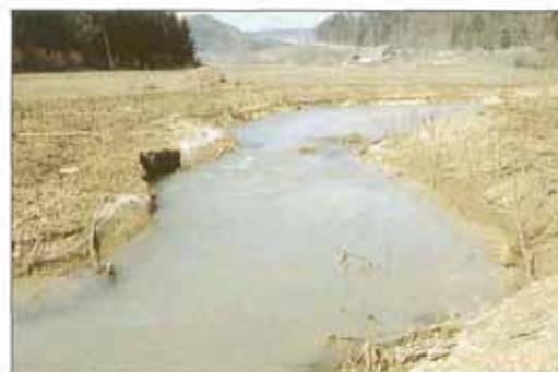
Abb. 113: Krähenbach, Bauabschnitt 1: Das Profil war für die auftretenden Abflüsse zu eng dimensioniert - Folge: Uferabbrüche, große Umlagerungen (Aufn: Klink 1992).
