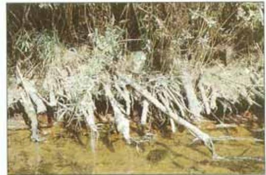
Abb. 128: Krähenbach, Bauabschnitt 1: Spreitlage zur Ufersicherung, stark unterspült, da fehlende Böschungsfußsicherung (Aufn.: LfU 1995).
