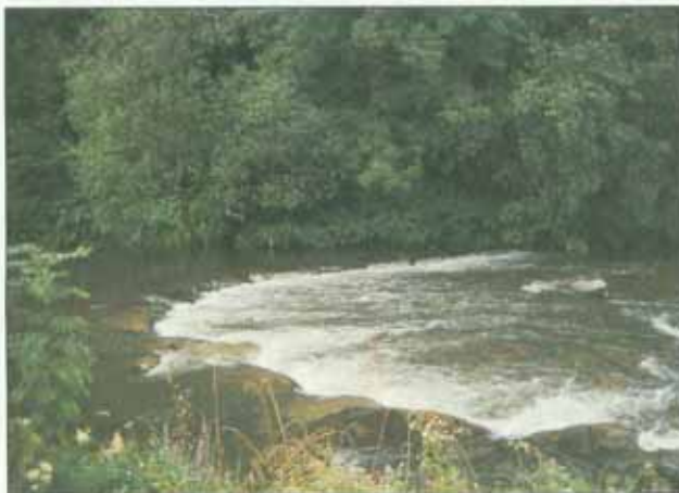
Ersatz von Abstürzen durch naturnah ausgebildete Sohlschwellen – Wiese bei Lörrach-Steinen (Aufn.: LfU, 41.2)
