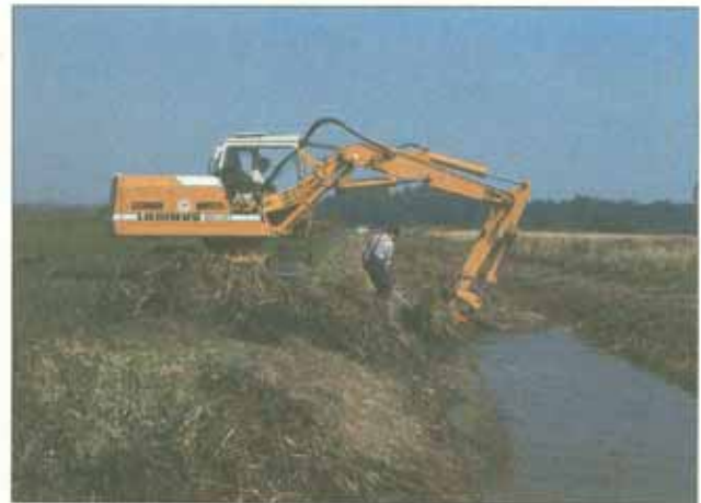
Landgestützte Krautung – Mähkorbeinsatz (Aufn.: Gewässerdirektion Rhein, Bereich Offenburg)
