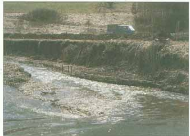
Sanierung eines Uferabbruchs mit Flechtzaun (Aufn.: RP Tübingen, Ref. 52)
