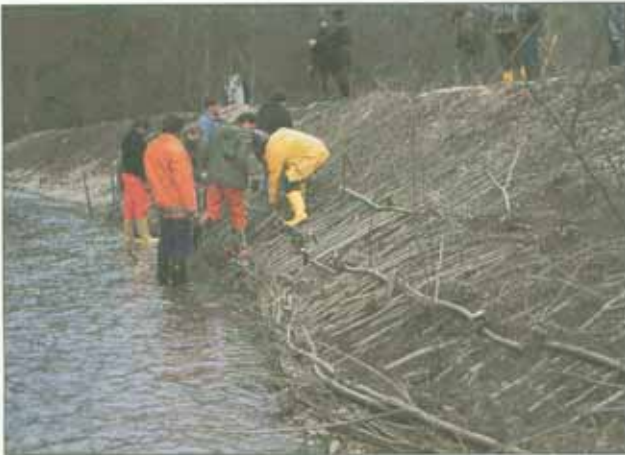
Ausführung einer Spreitlage mit Flechtzaun im Rahmen einer Gewässernachbarschaft (Aufn.: RP Tübingen, Ref. 52)
