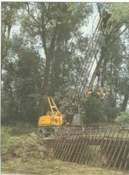
Krautfang – Mähgutentnahme mit Seilzugbagger (Aufn.: Gewässerdirektion Rhein, Bereich Offenburg)
