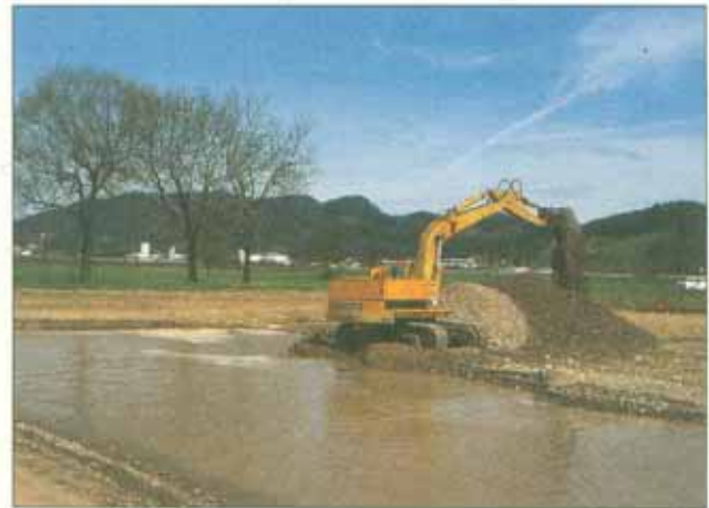
Sohlräumung (Aufn.: Gewässerdirektion Rhein, Bereich Offenburg)
