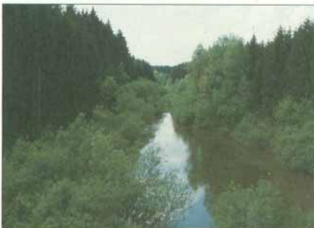
Auch Hochwasserrückhaltebecken müssen gelegentlich geräumt werden – HRB Tüferrot. (Aufn.: LfU, 41.2)
