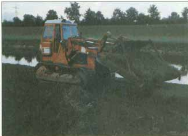
Grasnarbensicherung für die Wiederverwendung nach Vorlandabtrag (Aufn.: Gewässerdirektion Rhein, Bereich Offenburg)
