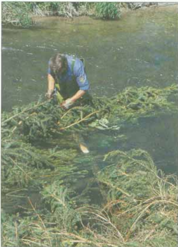
Einbringen eines Rauhbaumes (Aufn.: RP Tübingen, Ref. 52)
