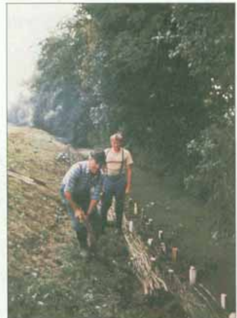
Faschineneinbau, zweilagig (Aufn.: Gewässerdirektion Rhein, Bereich Offenburg)
