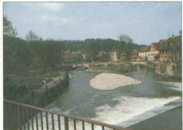
Anlandungen im Unterwasser eines Wehres in Ortslage – ein Problemfeld der Gewässerunterhaltung, Kocher, Schwäbisch Hall (Aufn.: LfU, 41.2)
