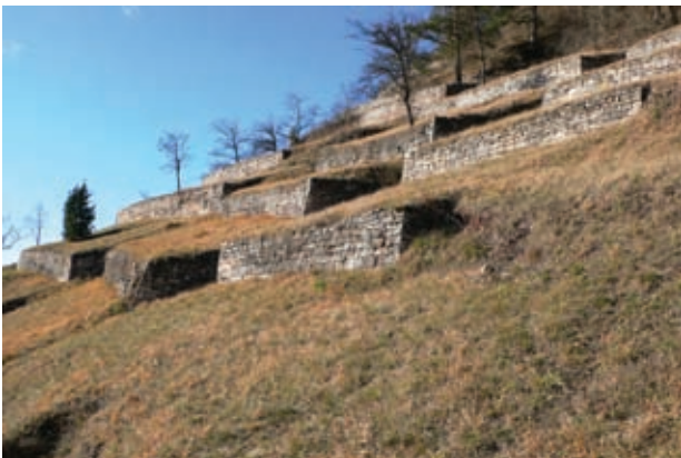
Trockenmauern aufgegebener Weinberge dominieren das Landschaftsbild im „Naturschutzgebiet Spitzberg“ bei Tübingen. Aufgelassene Weinberge bieten heimatgeschichtlichen und landschaftlichen Reiz, zugleich aber auch Nischen für eine artenreiche Flora und Fauna. Foto: C. Morrissey
