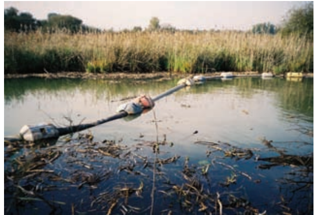
Bei der Ableitung des abgesaugten Schlammes müssen bis zur Deponiefläche teilweise Strecken von mehreren hundert Metern überwunden werden.
