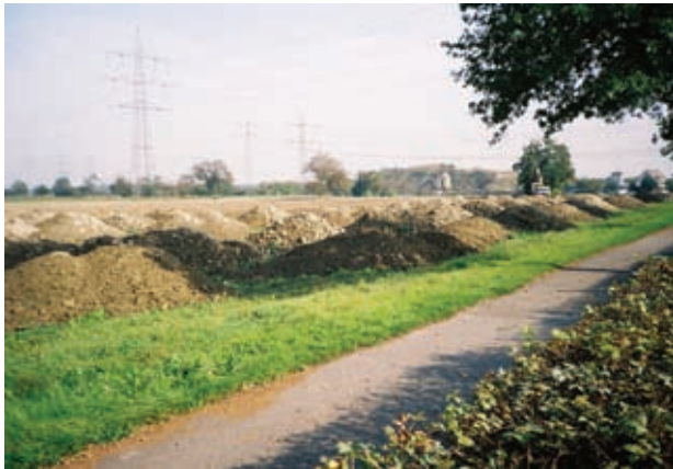
Der getrocknete Schlamm wurde von örtlichen Landwirten auf die Äcker gefahren und danach mit Baggern flächig verzogen. Am Ende war eine flächendeckende Geländeerhöhung von 15-20 cm erreicht.
