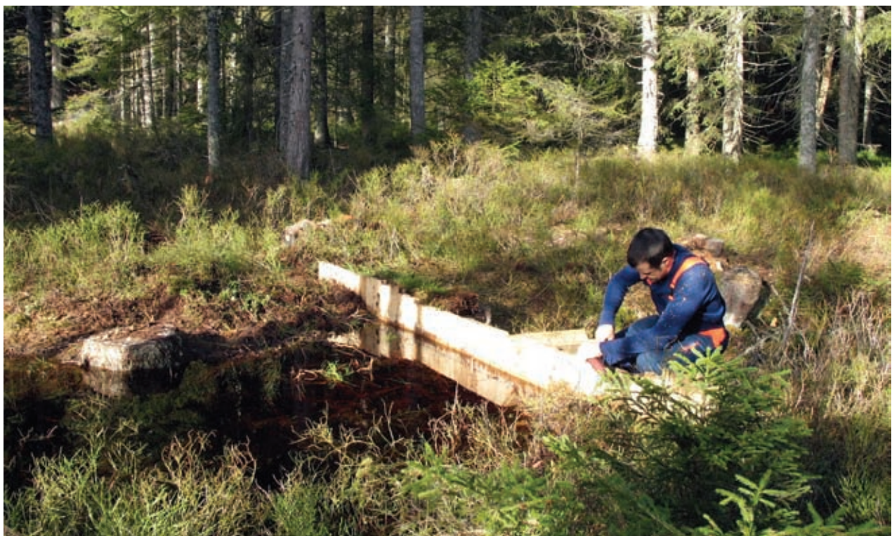
In den kleinen Mooren erfolgt der Sperrerbau überwiegend manuell.
