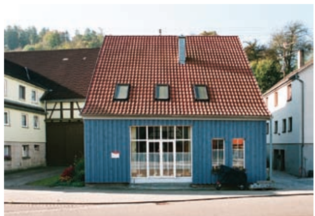
Günstig für eine Umnutzung war das Volumen einer leerstehenden Scheune in Creglingen-Münster. Die eichene Konstruktion über Natursteinmauern war die Basis einer geräumigen Wohnung mitten im Dorf.
