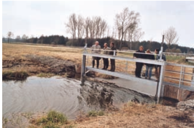
Neubau des Wehres im Abfluss des Federseekanals.
