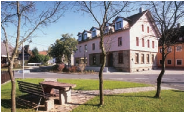
Der Badische Hof in Schlierstadt stand viele Jahre leer. Im Rahmen von MELAP entstand eine Metzgerei mit einem erweiterten Angebot, die zusammen mit dem Bäcker die Grundversorgung sichert. Foto: B. Walter (Stuttgart)
