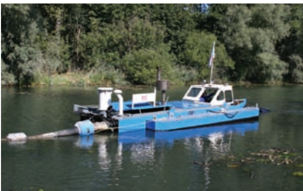
Schwimmbagger im Eggensteiner Altrhein Foto: RP Karlsruhe
