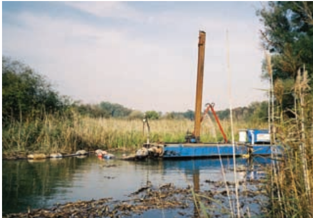
Die Entschlammungsmaßnahmen im „Eggensteiner Altrhein“ erforderten sowohl den Einsatz von Spezialgeräten wie einen sensiblen Umgang des Bedienungspersonals mit diesen Geräten in den wertvollen Naturbereichen, besonders an engen Gewässerstellen.
