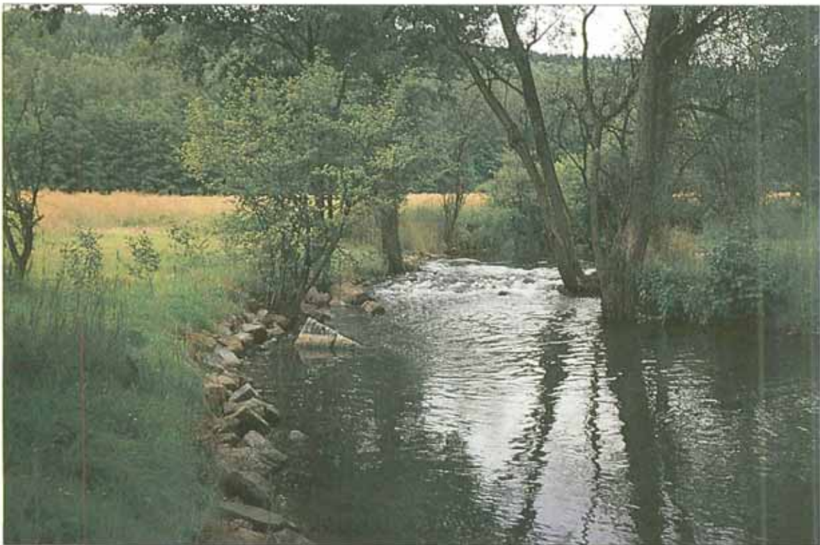
Bild 2: Sohlrampe in der Elsava, Einbindung zwischen bestehenden Bäumen. Sohlrampe wird gleichzeitig als Furt für die Landwirtschaft genutzt
