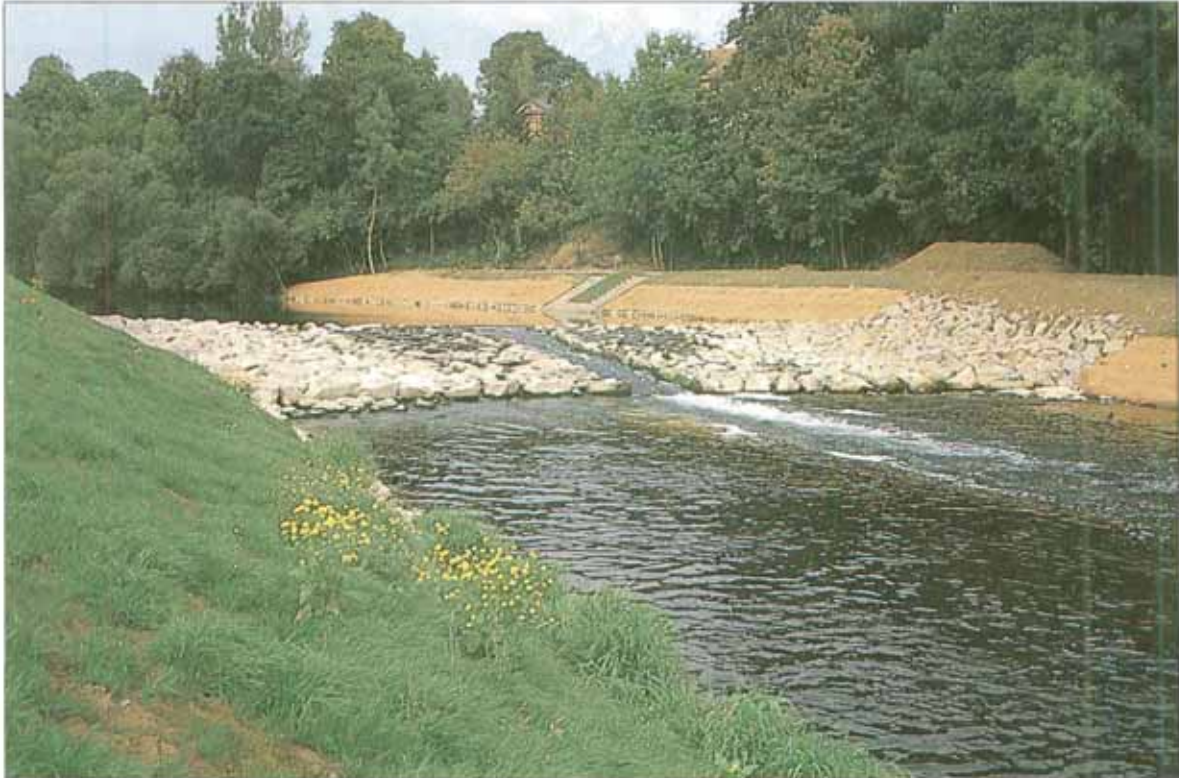
Bild 10: Rampe bei normaler Wasserführung, Abfluß über die Bootsrampe
