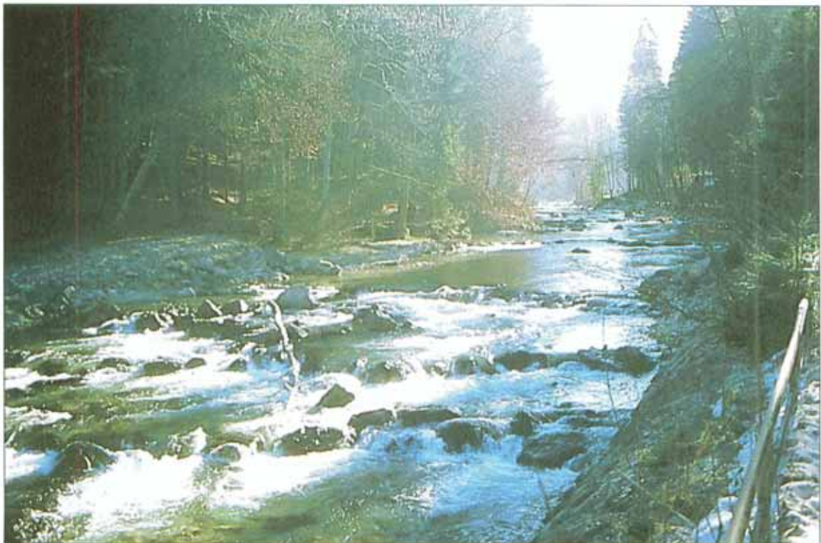
Bild 9: Sohlrampe i. d. Mangfall, Strukturvielfalt durch Riegelbauweise
