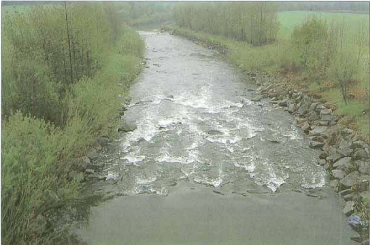
Bild 3: Rampe von OW gesehen, durchgehender Weidensaum am linken Ufer
