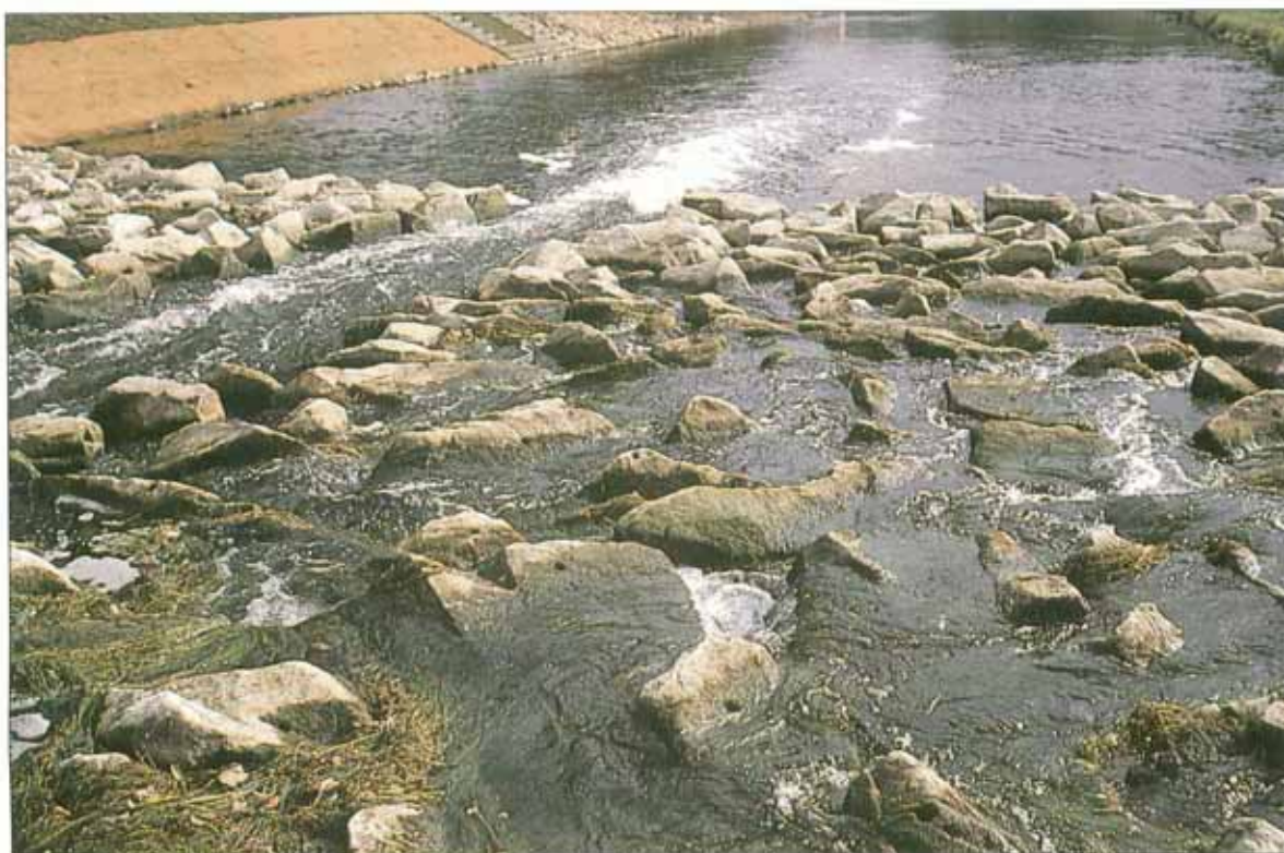
Bild 13: Durchströmtes Lückensystem der Steine, günstig für Organismenaufstieg
