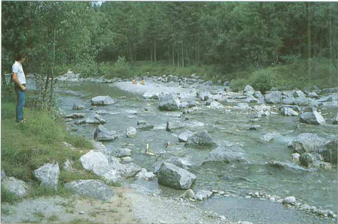
Bild 8: Sohlrampe i. d. Weissach (siehe Anlage 10) von OW gesehen
