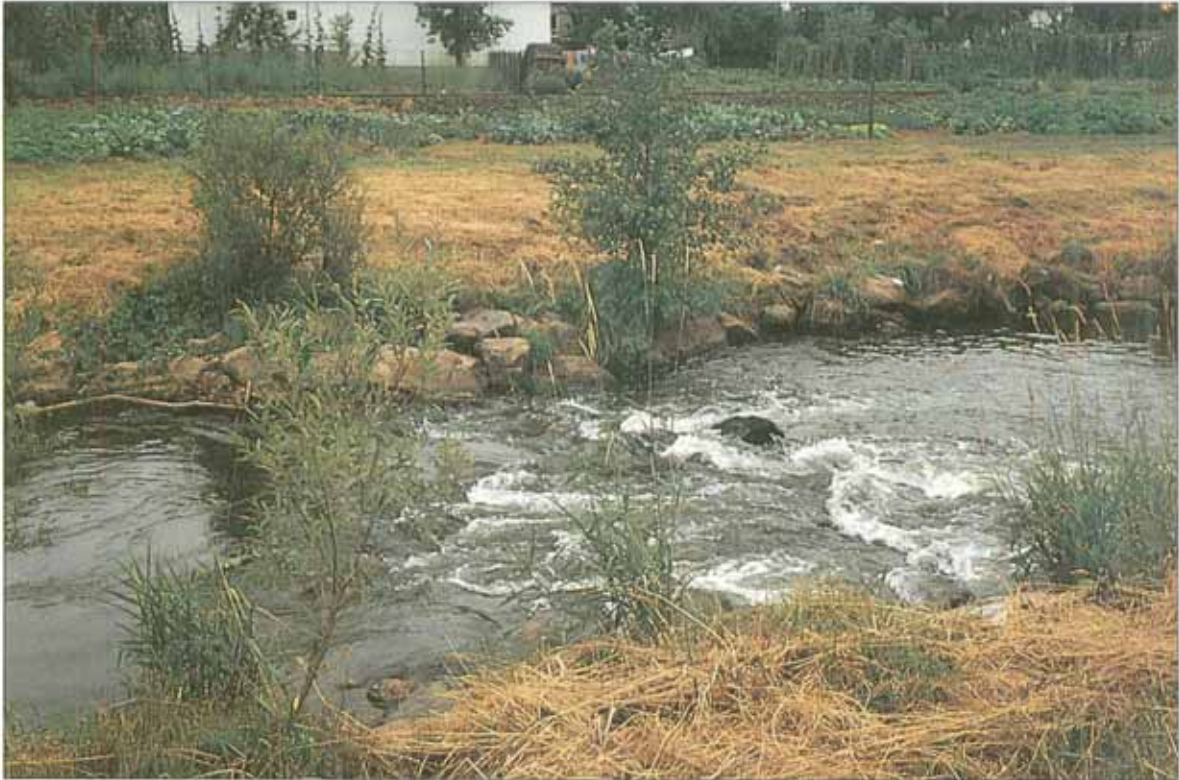
Bild 1: Sohlrampe in der Kahl, Böschungssicherung mit Steinen und Gehölz
