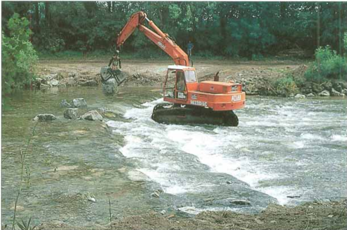
Bild 6: Setzen der Steinrampe
