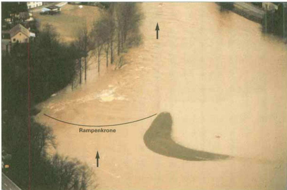
Bild 11: Rampe bei HQ = 460 \text{ m}^3/\text{s} (Feb. 1990) fast vollständiger Einstau, gewellter Oberflächenabfluß
