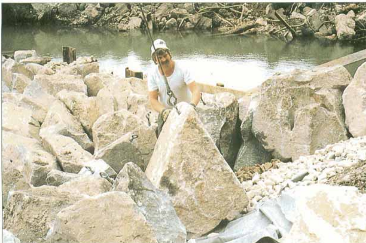
Bild 12: Setzen der Blocksteine
