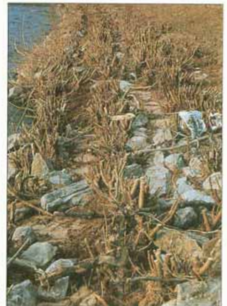
Steinschüttung mit Weiden (Stecklingspflanzung).
