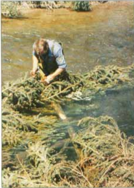
Im Wasser werden die Fichten zusammengekettet.
