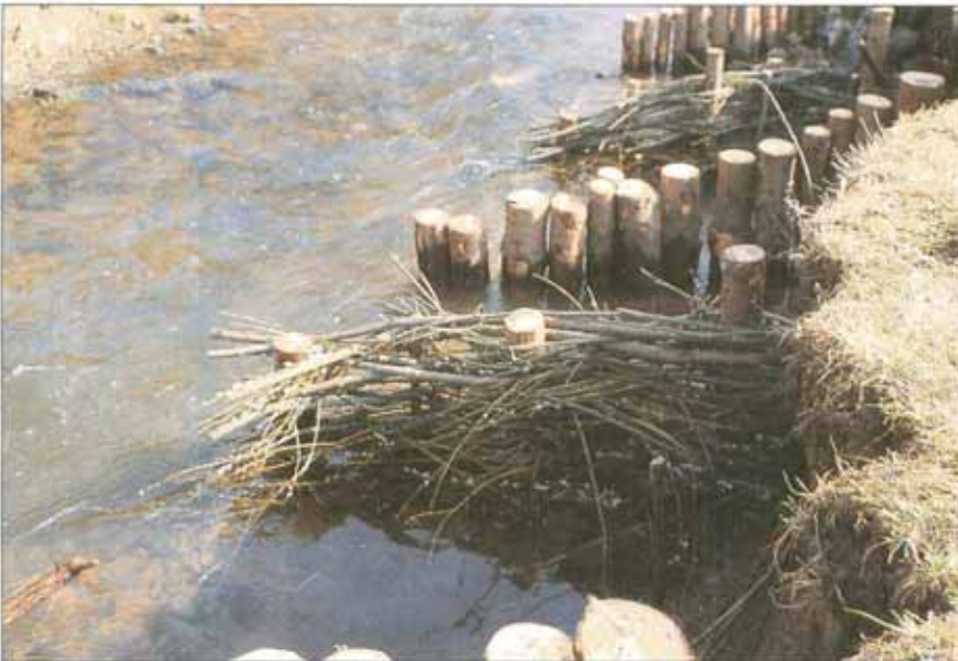
Die hydraulische und ökologische Wirkung sowie die Standsicherheit des Verbaus kann gesteigert werden, wenn die Buhnen abwechselnd aus verrottbaren Baustoffen und ausschlagfähigen Weiden hergestellt werden.
