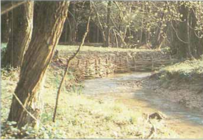
Lebender Flechtzaun fertiggestellt und zur Gehölzpflanzung vorbereitet.
