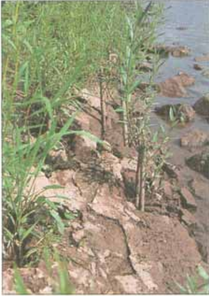
Schäden an einem älteren Böschungspflaster wurden durch Weidenstecklinge behoben.
