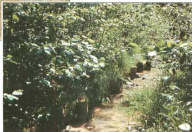
Durchmesser der Pfähle und Längsstangen zu groß gewählt, Verrottung lässt zu lange auf sich warten.
