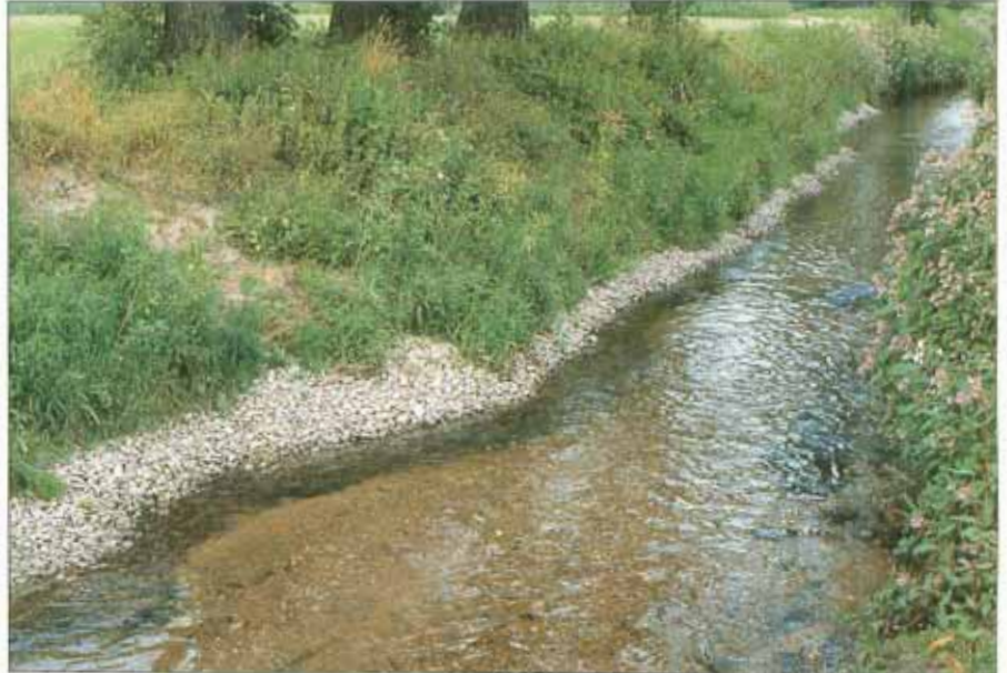
Steinschüttung als Unterkornbauweise, 3 Monate nach dem Einbau.
