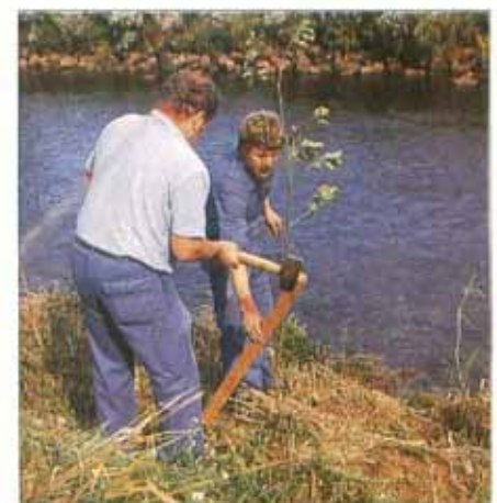
Einschlagen eines Pfahles zur Sicherung der Neupflanzungen bei Hochwasser.
