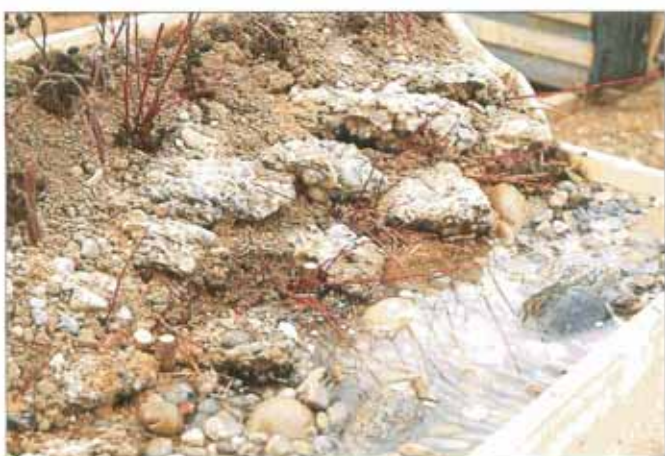
Fertig ausgeführte Ufersicherung (Modell). Die Ufergehölze sind in vorbereitete Pflanzlöcher versetzt; die übrige Böschung wird roh belassen.
