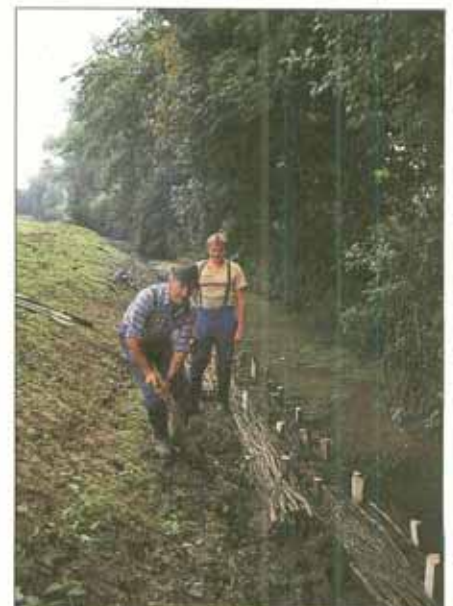
Hinterfüllen mit Erdmaterial.
