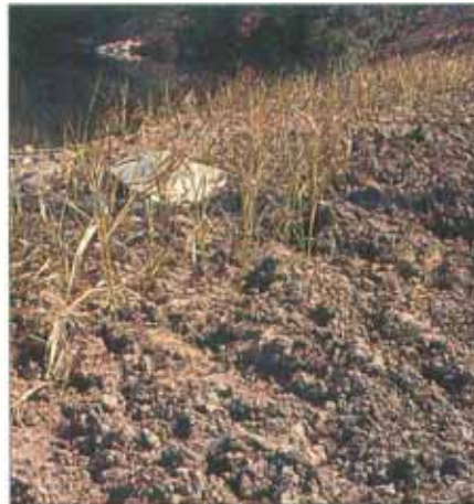
Herstellen eines ca. 2,5 m breiten Schilfgürtels auf einem Vorland. Die Halmpflanzung ist ca. 3 Wochen alt. Der Anwuchserfolg lag bei ca. 70 %.
