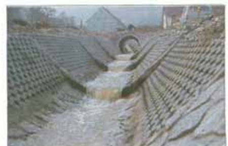
Der »Dorfbach« nach dem Ausbau (1975).
