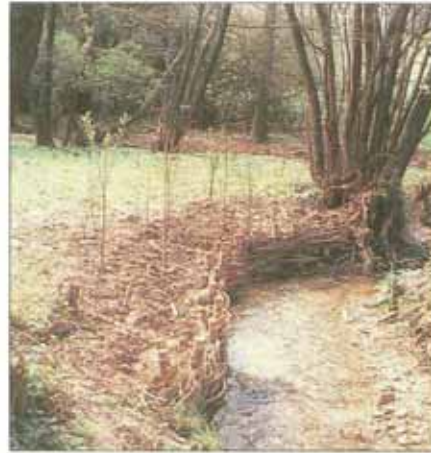
Der hinterpflanzte Flechtzaun bietet sofortigen Erosionsschutz.
