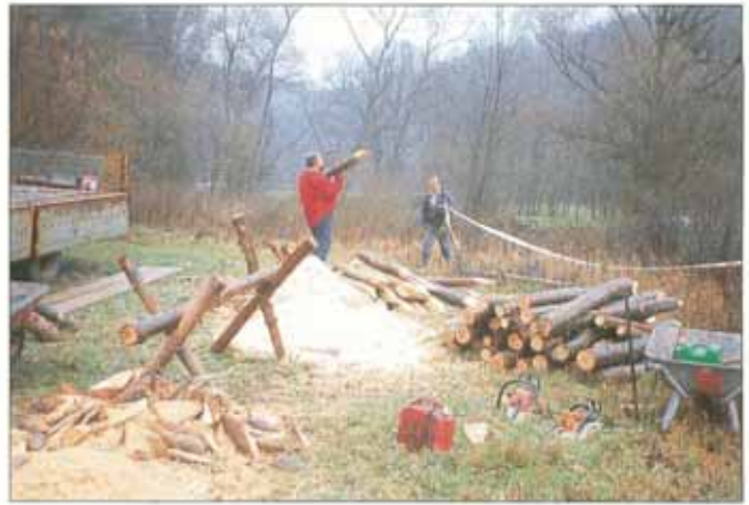
Nadelholzstangen \varnothing 10 – 20 cm, ca. 1,2 – 2 m lang auf Pfahlbock mit Kettensäge anspitzen.
