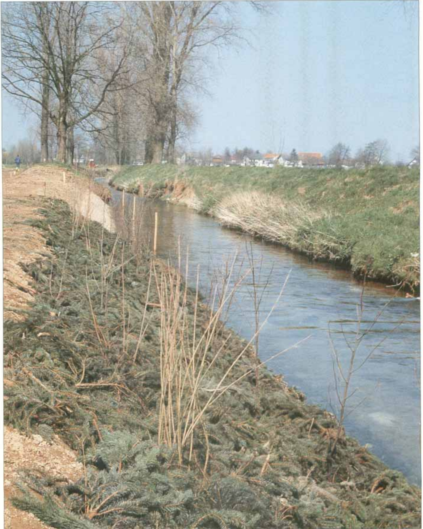
Frisch hergestellte Fichtenspreitlage mit Gehölzpflanzung.
