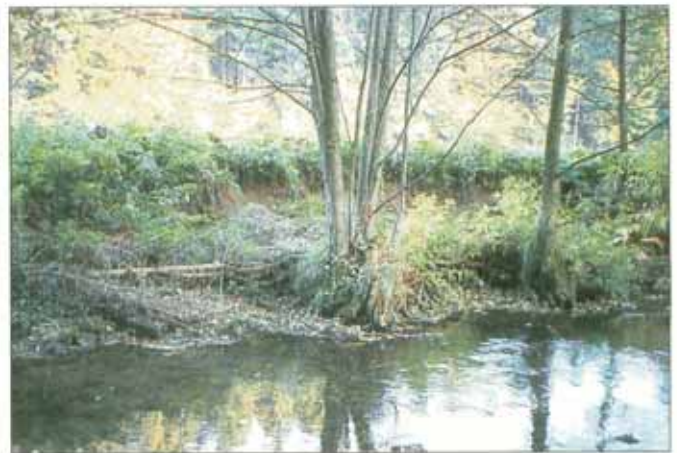
Nadelbäume ein- oder mehrlagig mit der Spitze in Fließrichtung einbringen und am dicken Ende verzurren.
