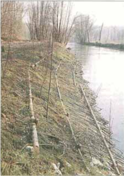
Fertig verlegte Spreitlage, Überspannung mit Nadelholzstangen.
