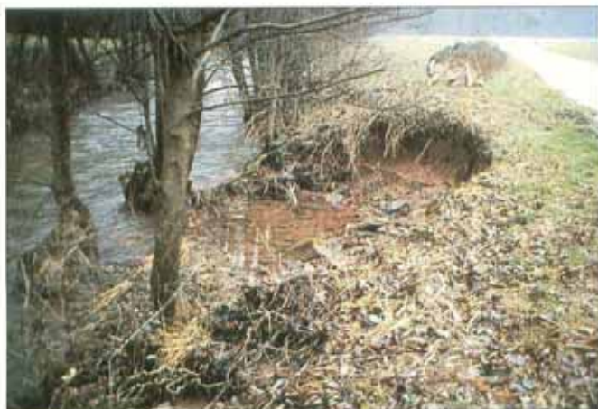
Sanierung eines Uferabbruchs auf einfache Weise; die als Baumaterial zu verwendenden Nadelgehölze, evtl. auch Baumkronen, lagern im Hintergrund.
