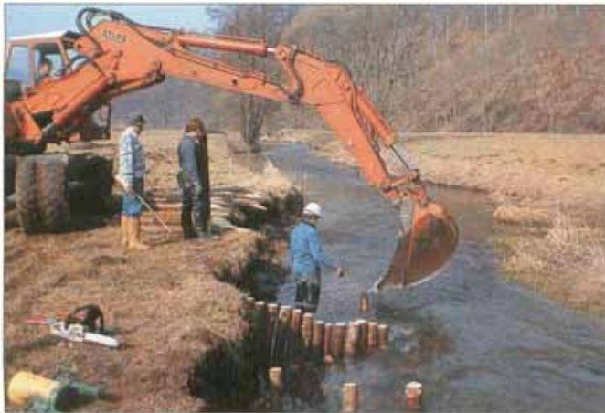
Pfähle buhnenartig mittels Bagger eindrücken. Je nach Untergrund gegebenenfalls mit Meisel vorbohren.
