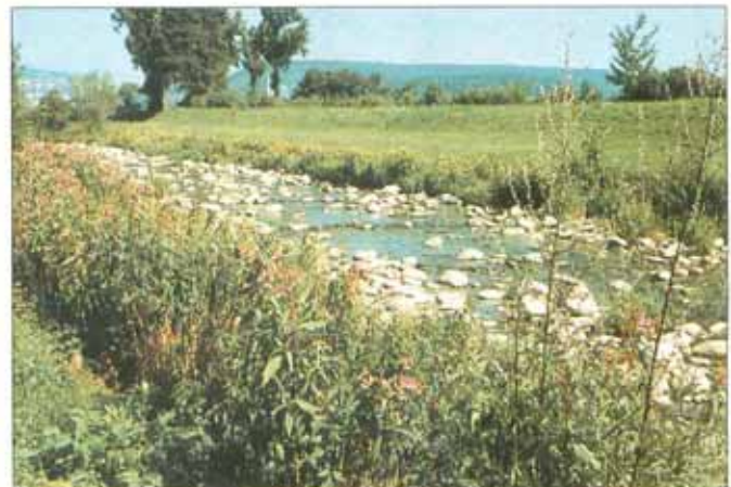
Ausgebauter Wildbach mit gegliedertem Ausbauquerschnitt. Im Verlaufe von ca. 50 Jahren hat sich in der Sohle wieder eine naturgemäße Kornverteilung mit Stützblöcken und schuppenartig geschichteten Geröllen eingestellt.
