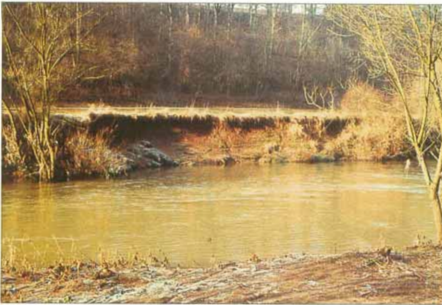
Uferabbruch kann nach Grunderwerb belassen werden.
