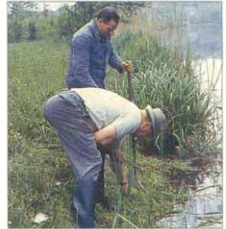
In die Pflanzlöcher werden 3 bis 5 Schilfhalm gesteckt. Die Halme dürfen dabei nicht gebrochen oder gequetscht werden.
