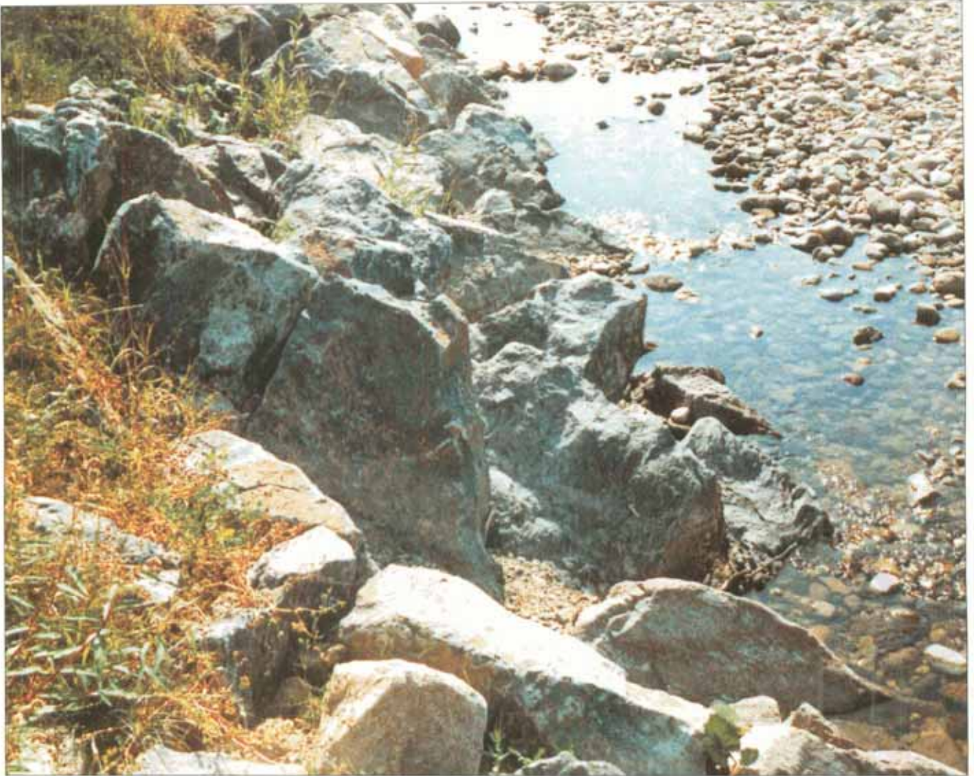
Ausgeführte Felsbanksicherung unterhalb eines Wehres. Das Steingerüst wurde mit Rohboden überdeckt. Es weist zahlreiche Nischen und Spalten als Lebensräume für Pflanzen und kleine Tiere auf (Fließrichtung von unten nach oben).
