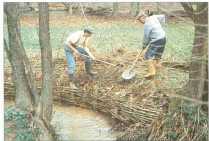
Verbleibende Böschung abschrägen und damit Arbeitsraum hinterfüllen, einschlämmen, um Weidenruten Substratkontakt zu bieten.
