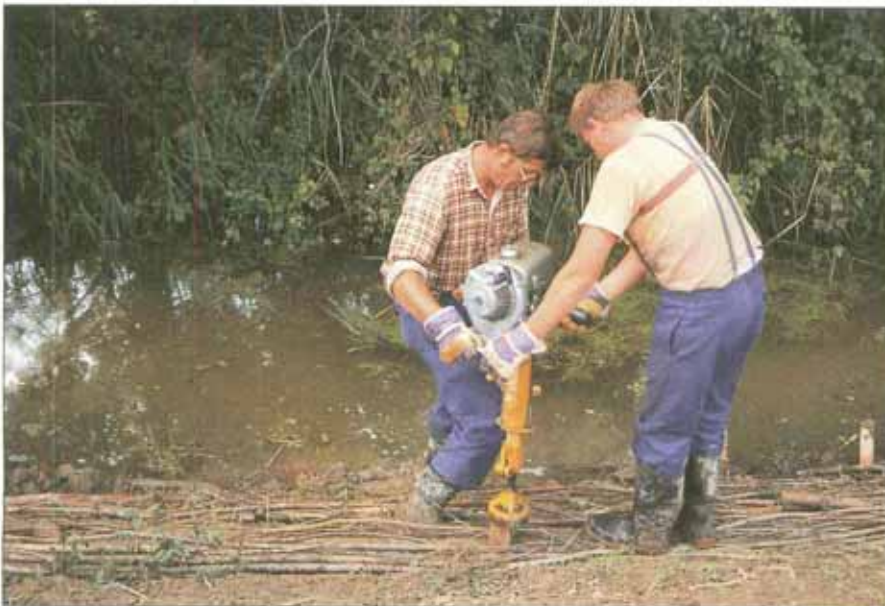
Einschlagen der Sicherungspfähle.
