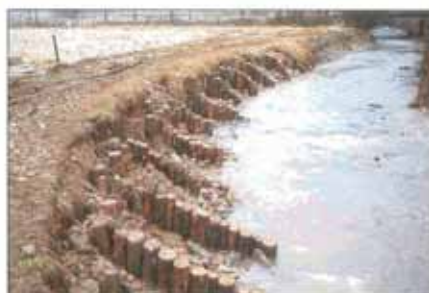
Fertiggestellter Pfahlbuhnenverbau; teilweise mit Geschiebe verfüllt und der Sukzession überlassen.
