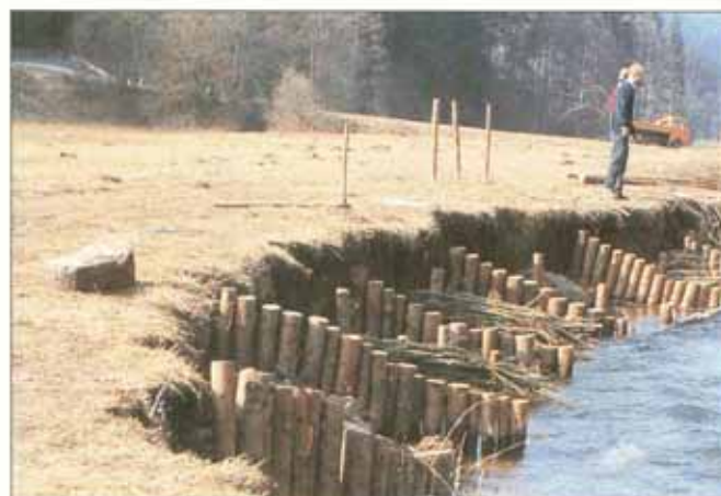
Die hydraulische und ökologische Wirkung sowie die Standsicherheit des Verbaus kann gesteigert werden, wenn die Buhnen abwechselnd aus verrottbaren Baustoffen und ausschlagfähigen Weiden hergestellt werden.
