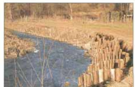
Fertiggestellter Pfahlbuhnenverbau; teilweise mit Geschiebe verfüllt und der Sukzession überlassen.
