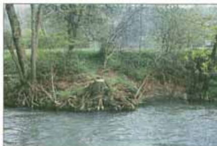
Ein vom Umstürzen bedrohter Erlenstock konnte durch Stockhieb erhalten werden. Die intakten Wurzeln sichern weiterhin das Ufer.
