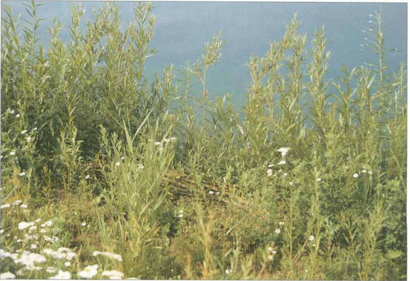
Ausgetriebene Faschinen ca. 4 Monate nach Einbau.
