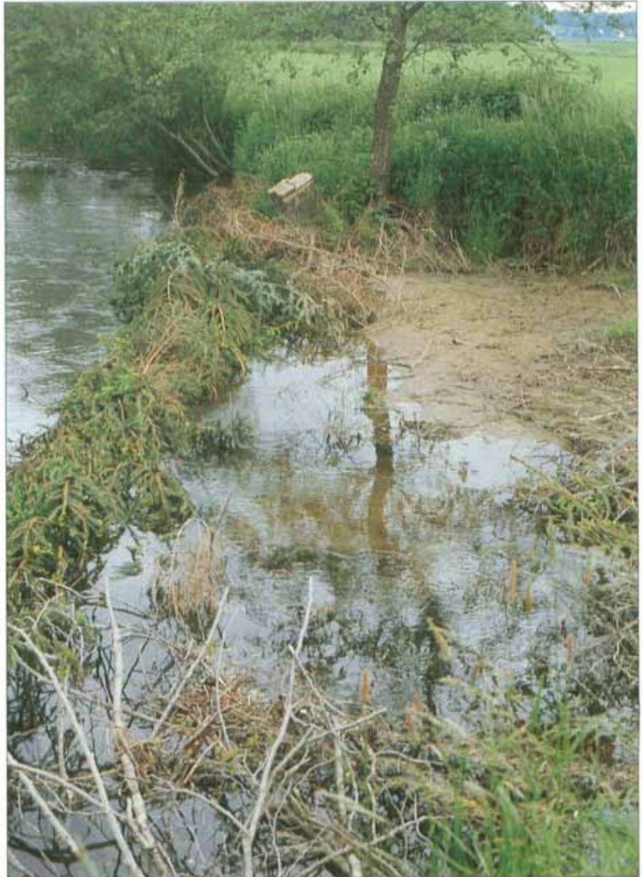
Uferabbruch durch Raubaumkette gesichert.
