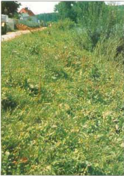
Begrünung einer Uferböschung ohne Ansaat. Die Gräser und Kräuter entwickelten sich aus den im angedeckten Oberboden enthaltenen Samen.
