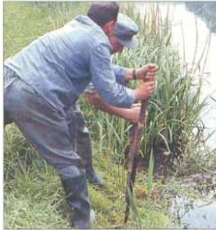
Herstellen eines Pflanzloches \varnothing 30 mm mittels einer Brechstange. Lochtiefe = halbe Halmlänge (40 bis 60 cm).
