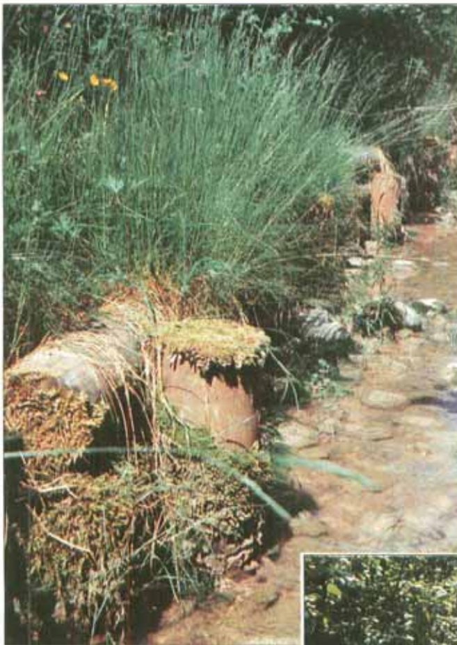
Durchmesser der Pfähle und Längsstangen zu groß gewählt, Verrottung lässt zu lange auf sich warten.
