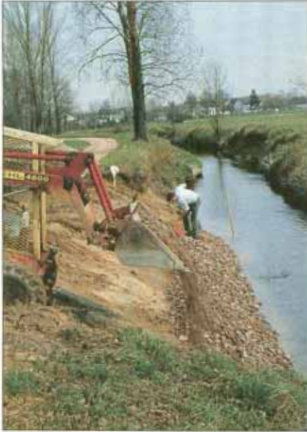
Unterkornbauweise, mit breitgestuftem Kornmischungsband, d_{\max} = 63 \text{ mm} , d_{\min} = 5 \text{ mm} .
