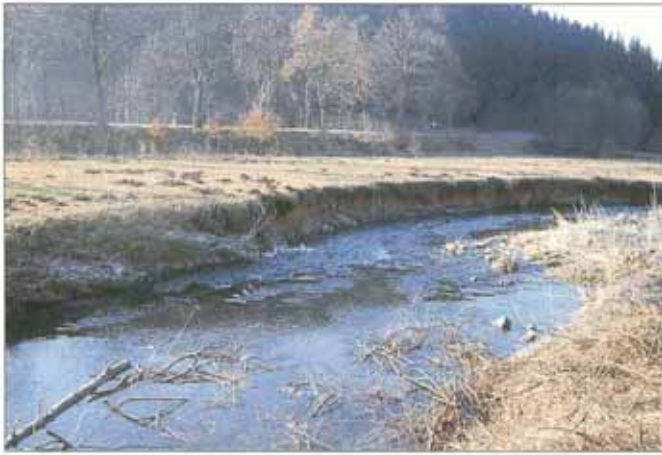
Ausgangszustand – Uferbruch am Prallhang, Kolkentiefe ca. 0,5 – 0,7 m.
