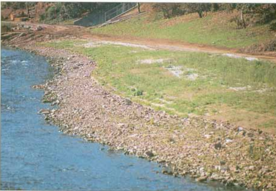
Sicherung des Ufers bis zum Mittelwasser mit Unterkornbauweise.
