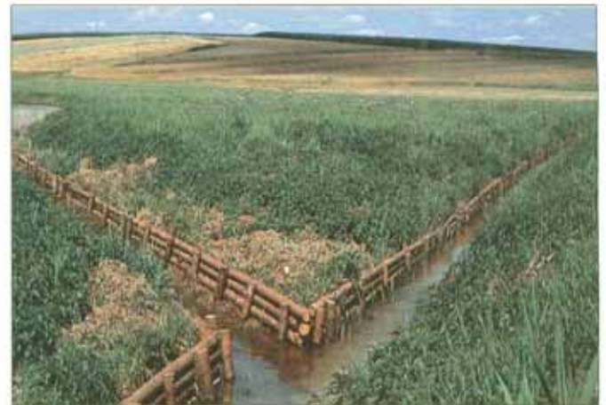
Negativbeispiel: auf langer Strecke wurden bis in die Überwasserzone Stangenverbau angewendet. Besser wären Gehölzpflanzungen auf erworbenem Uferstreifen.
