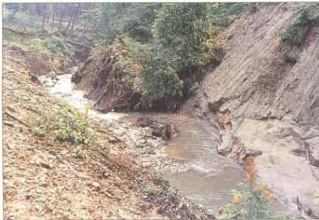
Geologisch bedingte Tiefenerosion eines Gewässers – Würmeiszeitliche Schotter über Süßwassermolasse. Durch Einbau eines Filters mit darüberliegender Sohlensicherung aus drei Kornfraktionen kann der Tiefenerosion Einhalt geboten werden.
