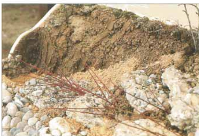
Naturgemäße Blockbauweise – Detailschnitt (Modell). Die Fließrichtung weist von rechts nach links. Die Blöcke fallen sowohl gegen die Fließrichtung als auch gegen das Ufer. Es entsteht ein treppenartiger Aufbau.
