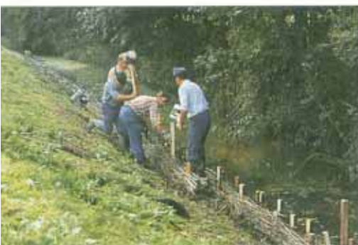
Einbau einer Faschine zur Böschungsfußsicherung.
