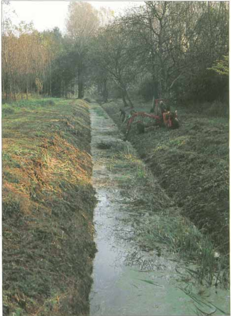
Krautung der Sohle und Böschungsmahd.
