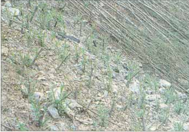
Wiederherstellen einer Dammbuchstelle in einem Naturschutzgebiet am Neckar. Bevor der endgültige Gehölzwuchs gepflanzt wird, erfolgt der Schutz durch schnellwachsende Weiden, die durch Spreitlage und als Stecklinge gepflanzt werden.
