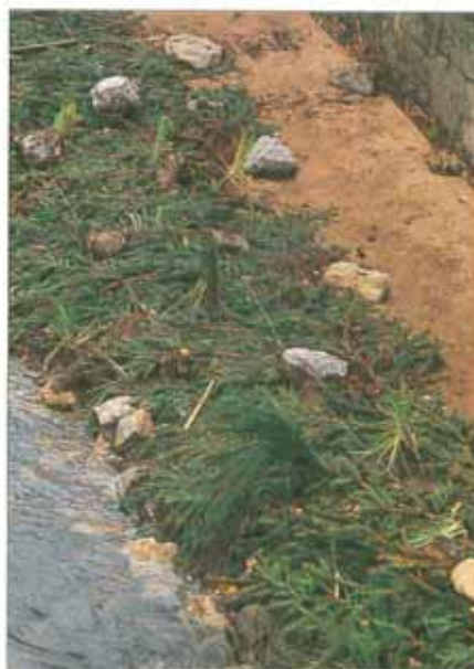
Eine noch im Oktober eingesäte Uferböschung. Um ein Abschwemmen des Oberbodens möglichst zu verhindern, wurde die Fläche mit Jute bzw. mit Fichtenreisern abgedeckt. Die zum Beschweren aufgelegten Steine wurden im folgenden Frühjahr an der Wasserwechsellinie eingebaut und später entfernt.
