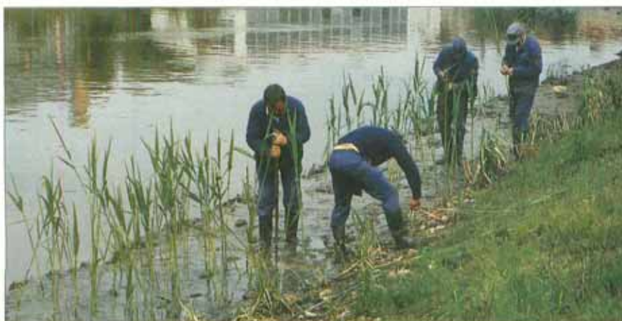
Bepflanzen einer Berme, die bei Mittelwasser etwa 15 cm überströmt wird. Pflanzabstand 20 bis 50 cm. In der Tiefe von 35 cm war der sonst schluffige Boden mit größeren Steinen durchsetzt. Die Halme wurden z. T. nicht tief genug eingesteckt. Besser wäre hier eine Ballenpflanzung gewesen.
