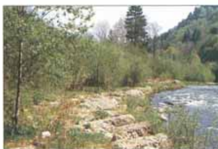
Ausführungsbeispiel mit Blöcken aus Nagelfluh. Man beachte die Schräglage der Blöcke.
