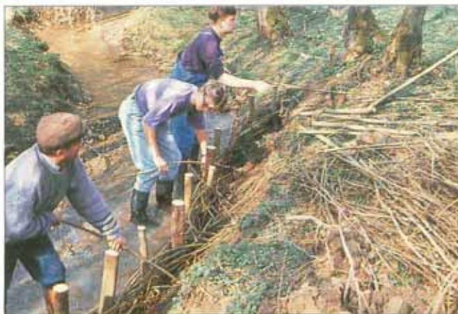
Biegsame, ausschlagfähige Weidenruten mit dem dickeren Ende in den Boden, am besten bis in den Unterwasserbereich stecken und nach Korbmacherart durch die Pfahlreihe einflechten.
