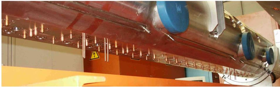
Bild 7.67: Durch den Tankboden geführte Kühlleitungen (138 Kanäle), Leitungen in einer Reihe führen zu einer Stütze.
