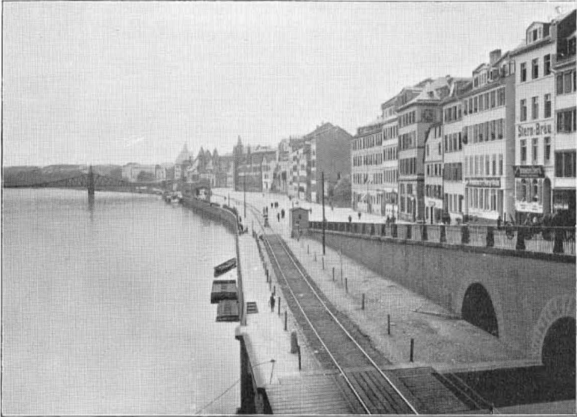
Mainkai unterhalb der Alten Brücke.
