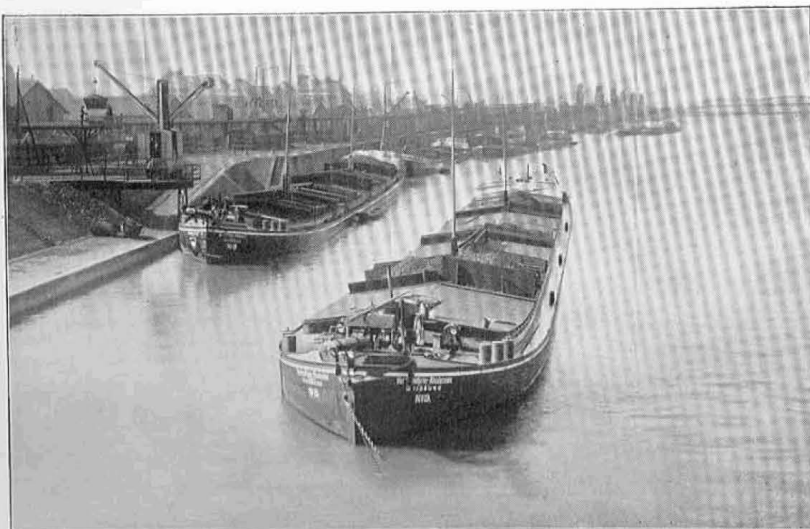
Kohlenhafen unterhalb der Wilhelmsbrücke.
