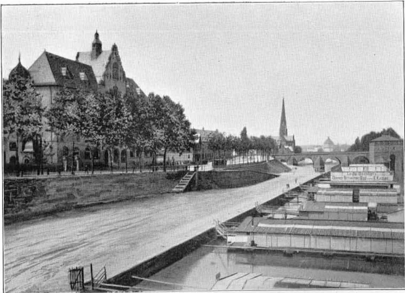
Deutschherrnkai unterhalb der Obermainbrücke.
