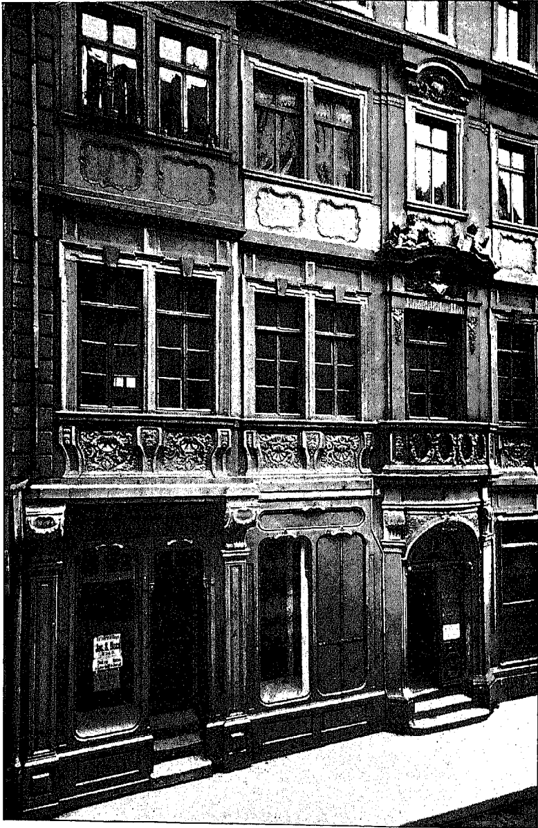
Fig. 119. Engelthaler Hof; Theil der Façade.
