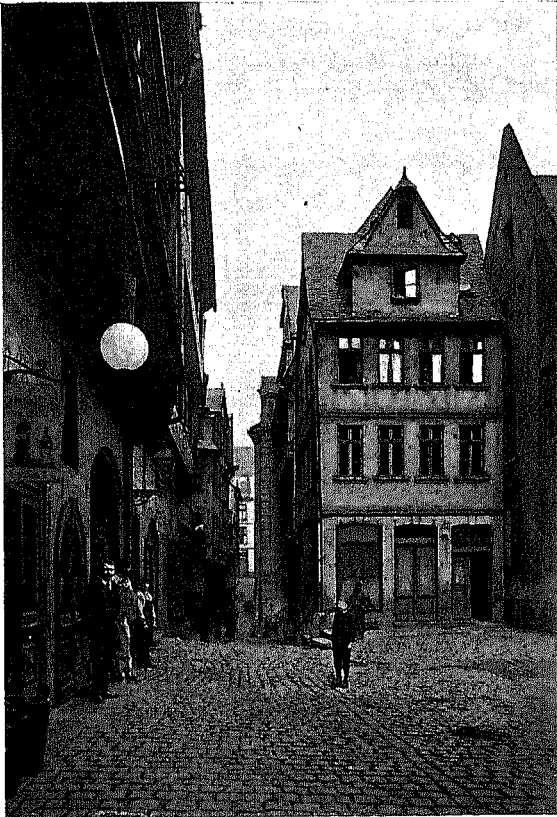
Fig. 268. Hof Rebstock am Markt; Blick in die Krug-Gasse. Rechts Haus Nr. 6.
