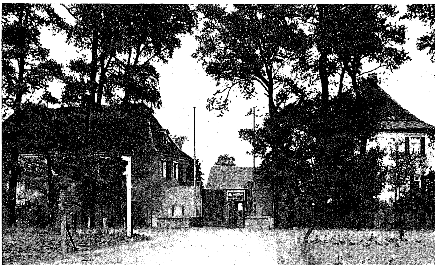
Fig. 249. Stralenberger Hof; Eingang von Westen gesehen.
