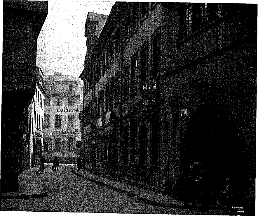
Fig. 329. Arnsburger Hof; Nordfront an der Prediger-Strasse.
