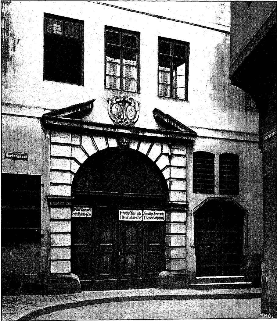
Fig. 288. Clesern-Hof; Thorbau an der Kerhen-Gasse.
