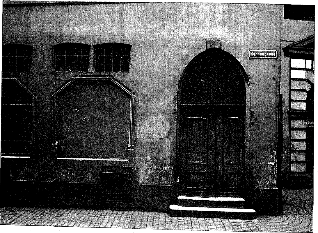
Fig. 287. Clesern-Hof; Messläden an der Kerben-Gasse.
