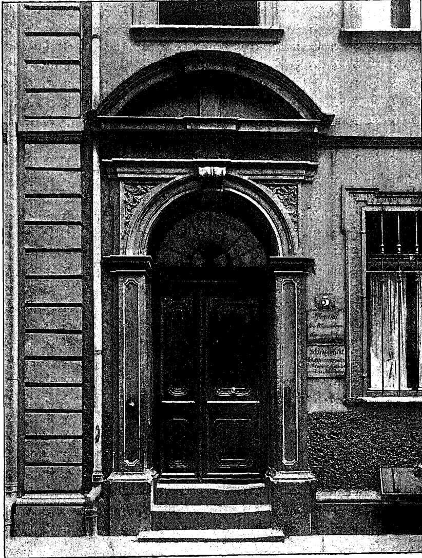
Fig. 333. Arnsburger Hof; Portal an der Nordfront.
