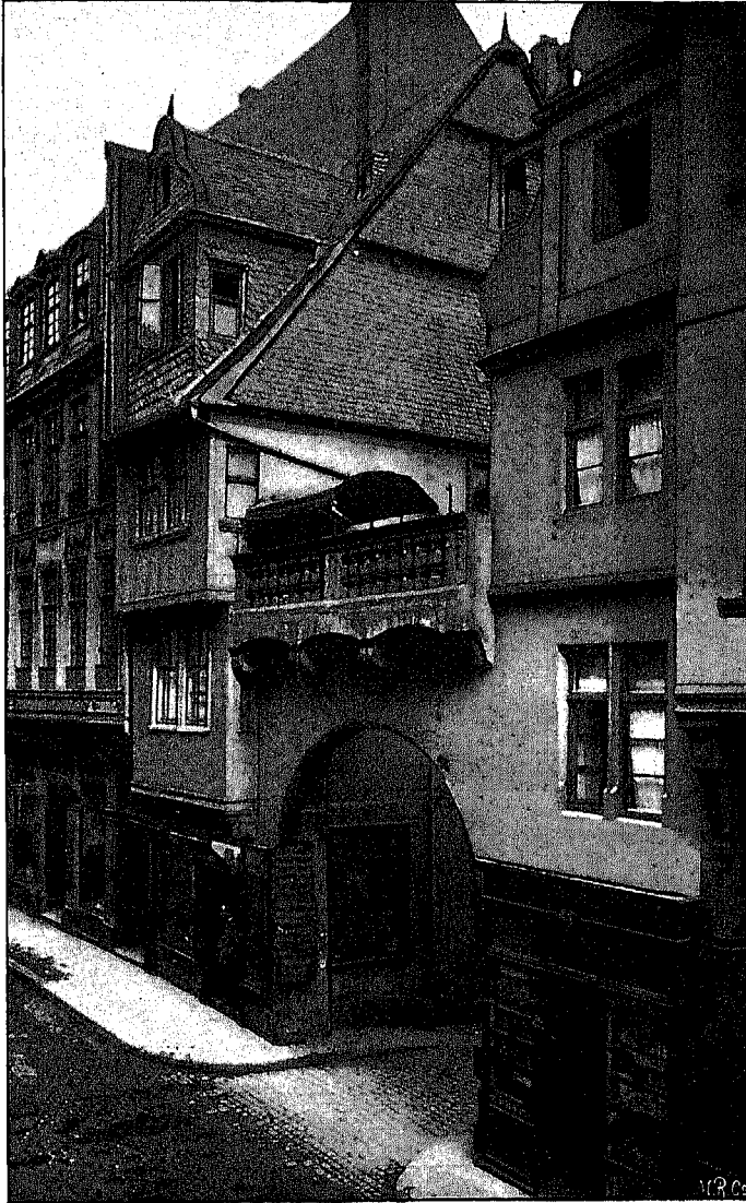
Fig. 262. Nürnberger Hof; Eingang an der Schnur-Gasse.
