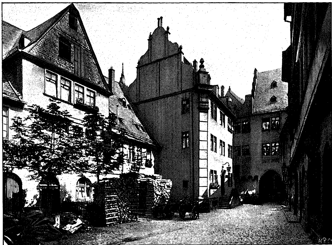
Fig. 253. Nürnberger Hof; innere Ansicht nach Süden gesehen. Vor dem Durchbruche der Braubach-Strasse (1904).
