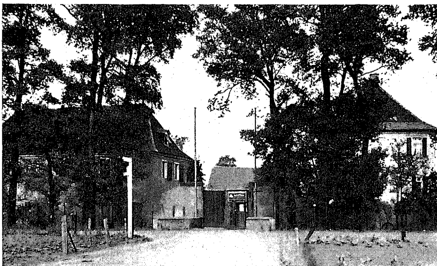
Fig. 249. Stralenberger Hof; Eingang von Westen gesehen.
