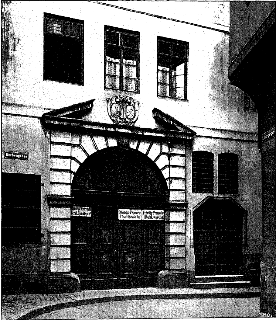
Fig. 288. Clesern-Hof; Thorbau an der Kerhen-Gasse.
