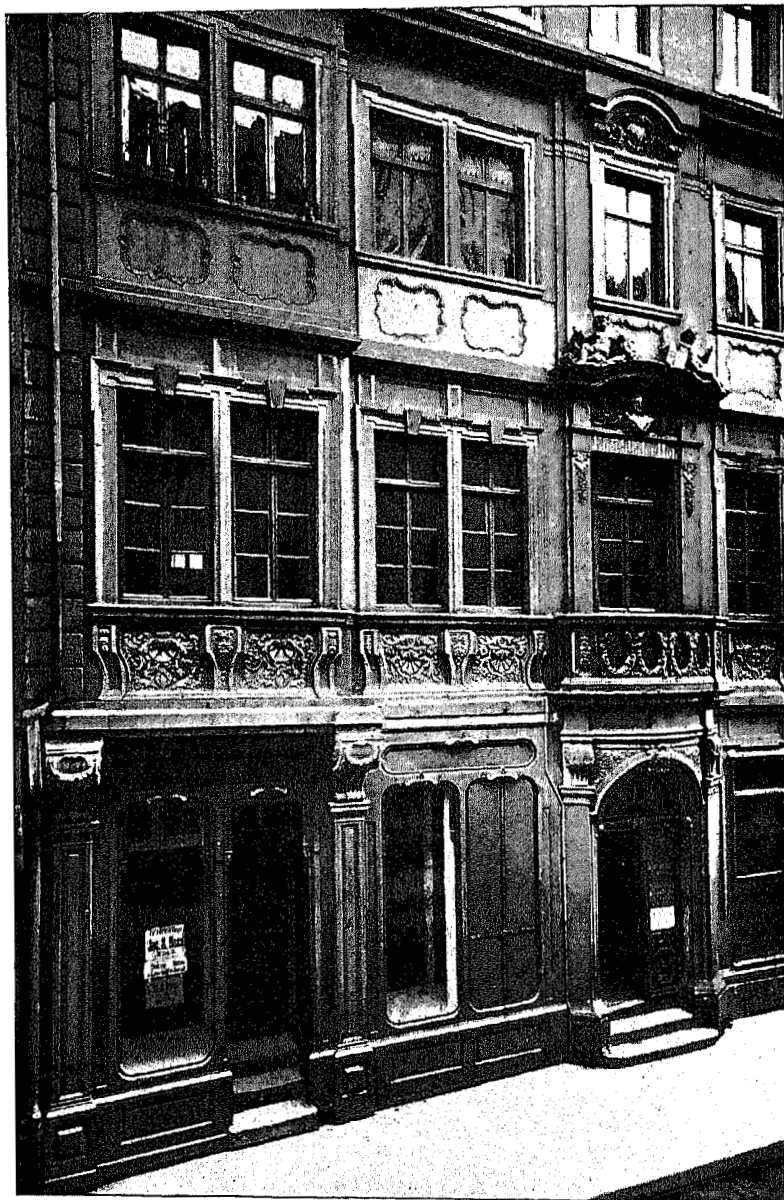
Fig. 119. Engelthaler Hof; Theil der Façade.
