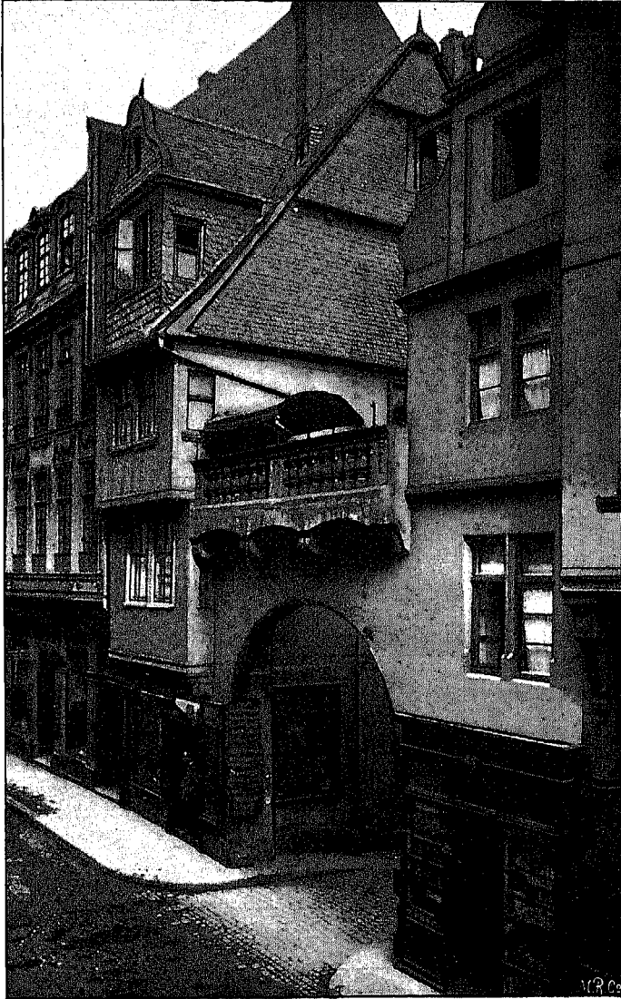
Fig. 262. Nürnberger Hof; Eingang an der Schnur-Gasse.
