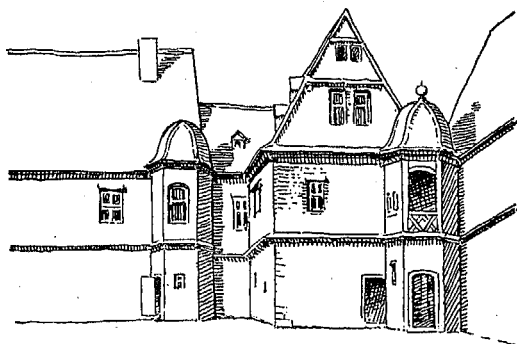
Fig. 319. Grosser Tauben-Hof; Nordwestseite. Nach Reiffenstein (1856).
