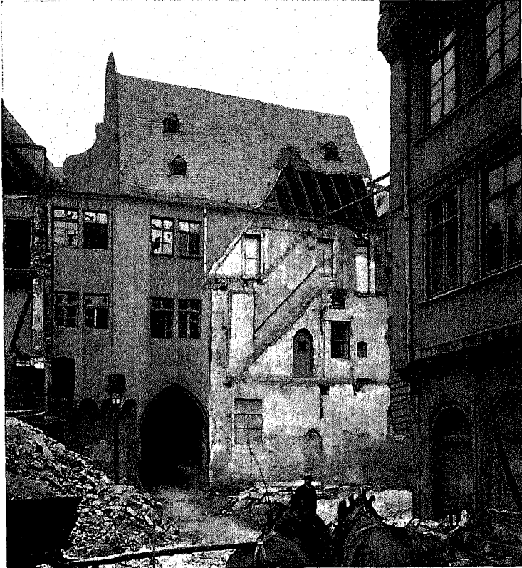
Fig. 254. Nürnberger Hof; innere Ansicht nach Süden gesehen. Während des Durchbruches der Braubach-Strasse.
