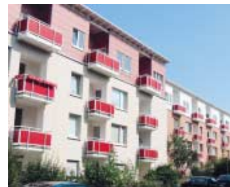
Die aufgestockten Geschosse sind farblich abgesetzt.
