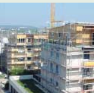
Aufstockungsarbeiten in der Begienklausen
