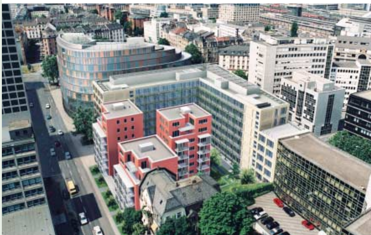
Grundsteinlegung der Frankfurter Aufbau AG am Baseler Platz
