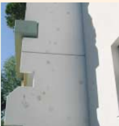
Bilder ganz oben: Die Liegenschaft „Auf dem Schafberg“ vor und nach der Fassadeninstandsetzung. Angrenzende Bilder: Häuser in der „Schöffenstrasse“ vor und nach der Fassadeninstandsetzung. Bild unten links: Instand gesetzte Fassade „Zum Heidebuckel“: Verschmutzungen nach nur wenigen Monaten.
